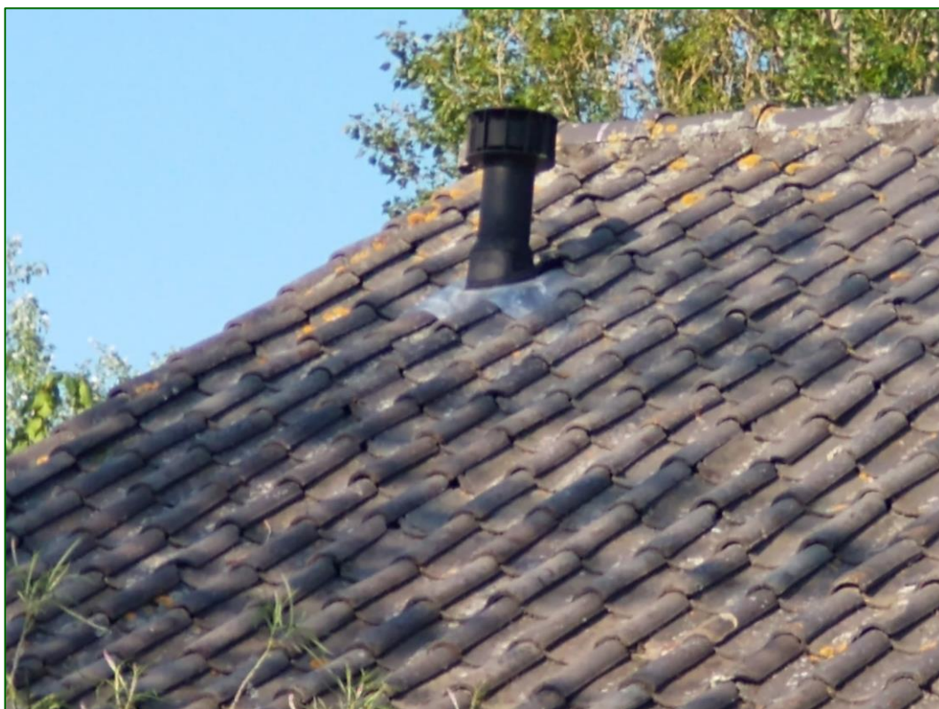
Figuur 2: Dak met schoorsteen van het gepotdekselde gebouw.
