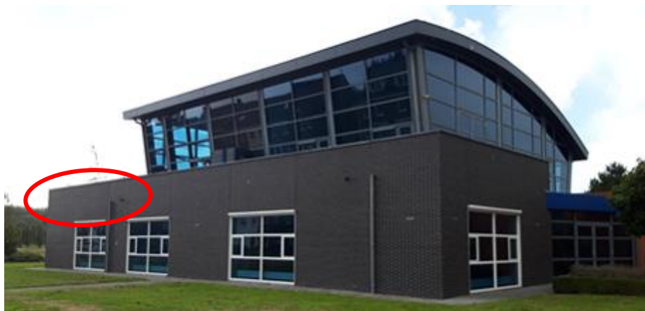
Figuur 4.2. Locatie van de aangetroffen zomerverblijfplaats
