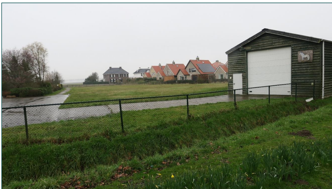
Figuur 2 Het grootste gedeelte van de planlocatie bestaat uit kort gemaaid gras. Rechts op de foto de te slopen schuur.
