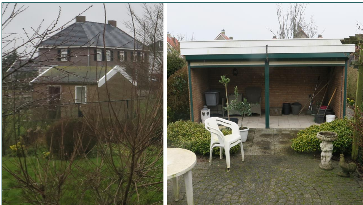
Figuur 1.5 Links: het kippenhok is opgetrokken uit bakstenen muren zonder luchtsponw met zadeldak bestaande uit platen met dakbeschot. Rechts: het tuinhuis is opgetrokken uit bakstenen muren zonder luchtsponw met plat bitumen dak.
