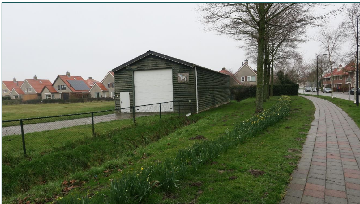
Figuur 1.5 De schuur is opgetrokken uit gepotdekselde rabatdelen met golfplaten zadeldak zonder dakbeschot.
