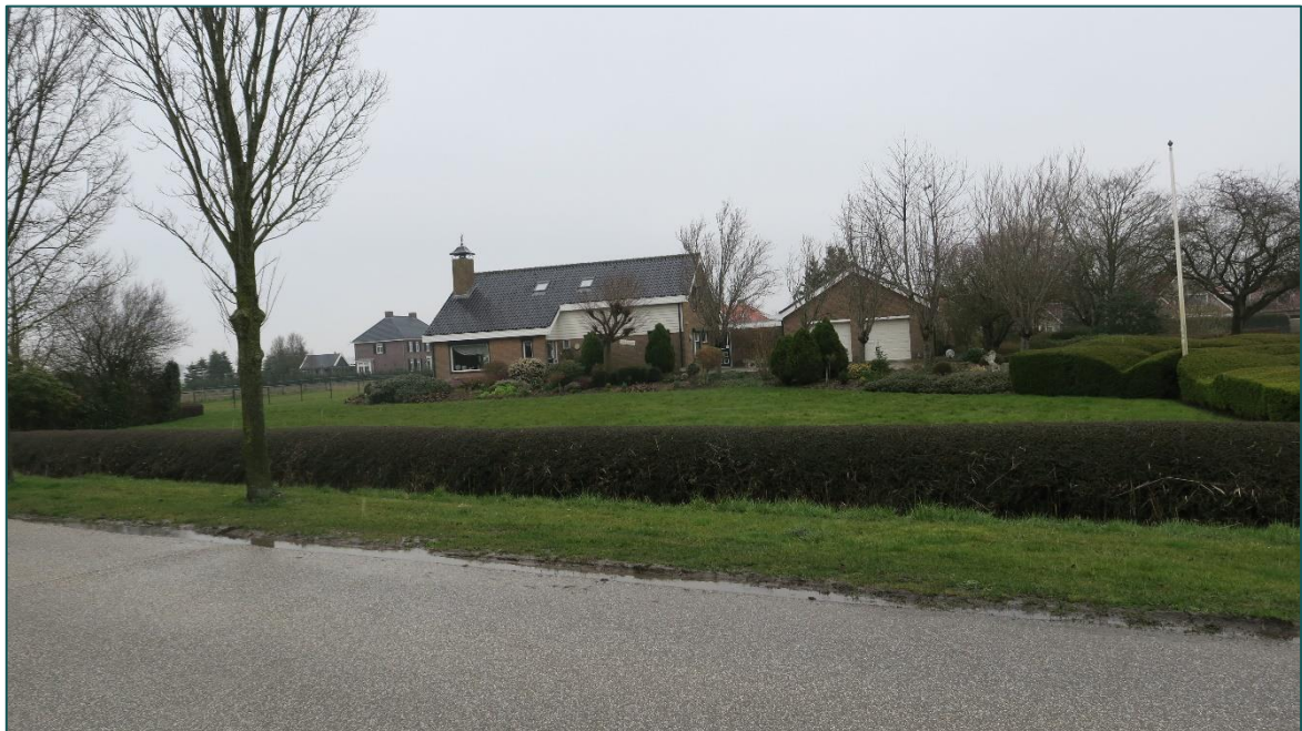
Figuur 1.3 De planlocatie (rood omkaderd) is gelegen aan de Jacob Catsstraat 8 te Sommelsdijk. De woning en garage zijn opgetrokken uit bakstenen muren met luchtsponw en een dakpannen zadeldak. Door middel van een uitbouw met plat bitumen dak is de woning met de garage verbonden.
