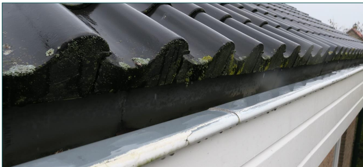
Figuur 3.2 De dakpannen zijn dicht aan de voorzijde, waardoor huismussen de dakruimte niet kunnen betreden.
