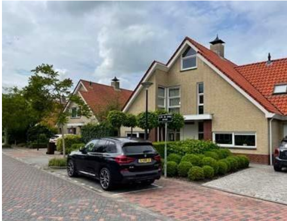
Woningen A.M. de Jonghstraat
