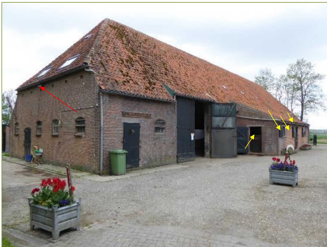
Foto 3: de grote schuur wordt verbouwd tot appartementen. De rode pijl is de broedplaats van de Turkse tortel. De gele pijlen zijn de invliegopeningen van de boerenzwaluwen in de aanbouw.
