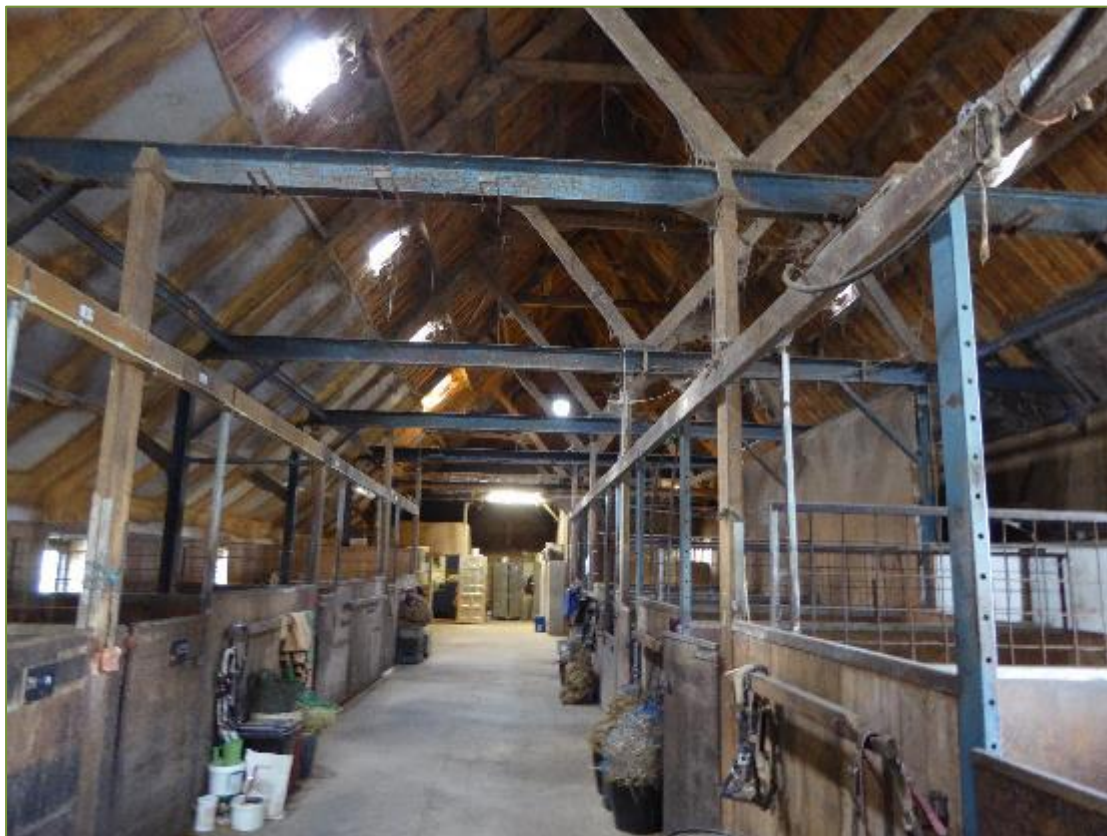
Foto 1: de grote schuur. Hier zijn geen krijtsporen, veren of andere sporen aangetroffen van bv de kerkuil en boerenwaluw. Er is geen afgesloten donkere zolder waar eventueel vleermuizen kunnen verblijven.
