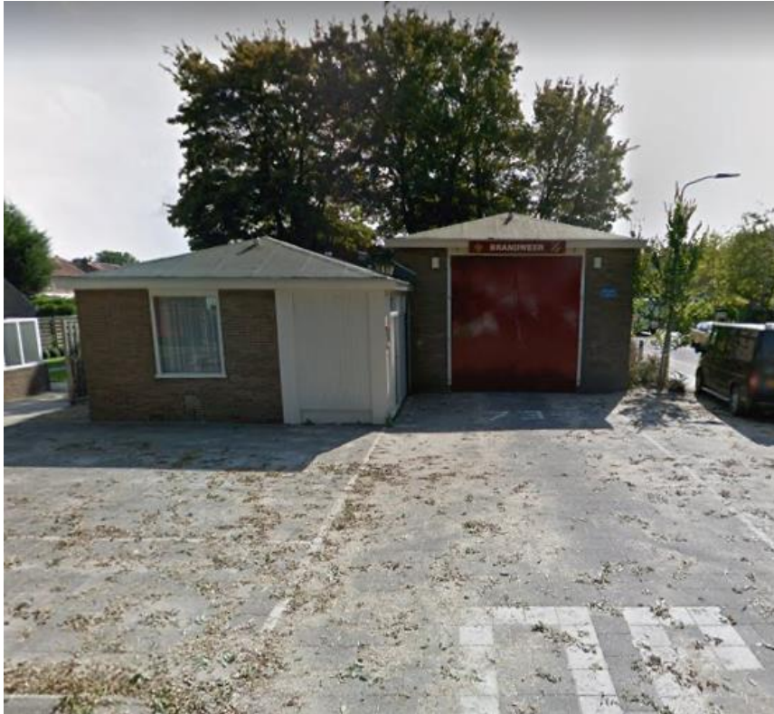
figuur 1.4 foto voorzijde huidige bebouwing
