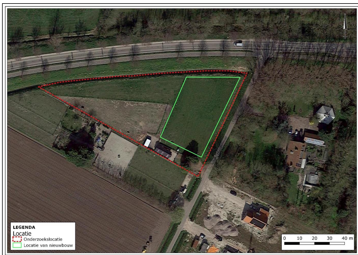
Figuur 9. Luchtfoto met een globale omlijning waar de werkzaamheden zullen plaatsvinden.
