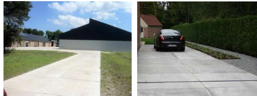
betonplaten/ stelconplaten (of eventueel asfalt)
