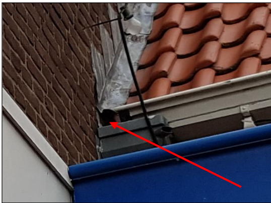
Foto 9: Ruimte tussen loden dakbekleding van de boerderij in het plangebied
