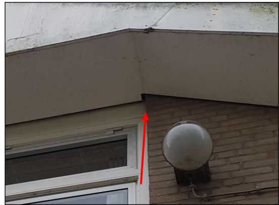
Foto 8: Ruimte onder het dakbeschot van het schoolgebouw
