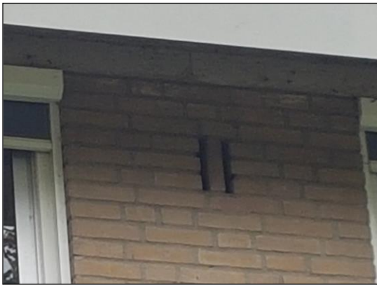
Foto 7: Spouwgoten in de muur van het schoolgebouw in het plangebied
