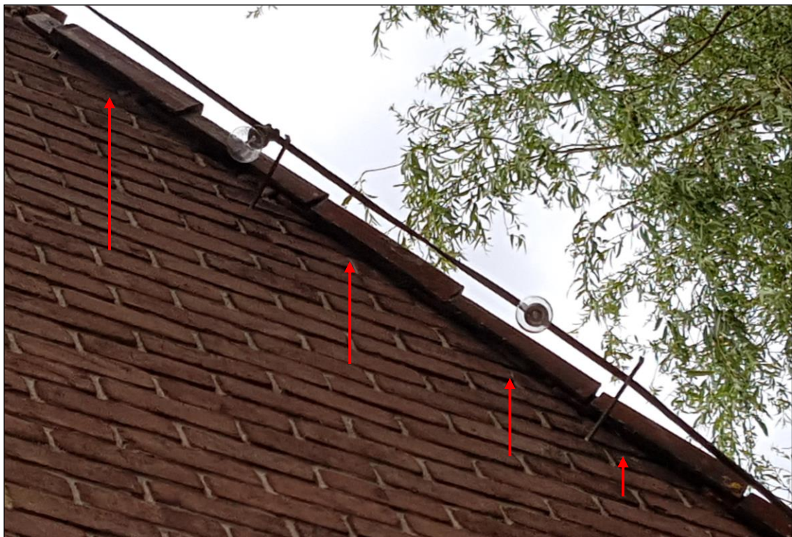
Foto 11: Geschikte ruimte tussen de dakpannen en de muur van de boerderij in het plangebied
