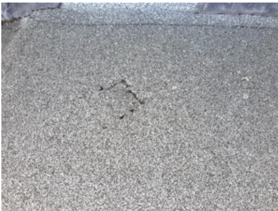
Foto F05, dakbitumen - Dak
