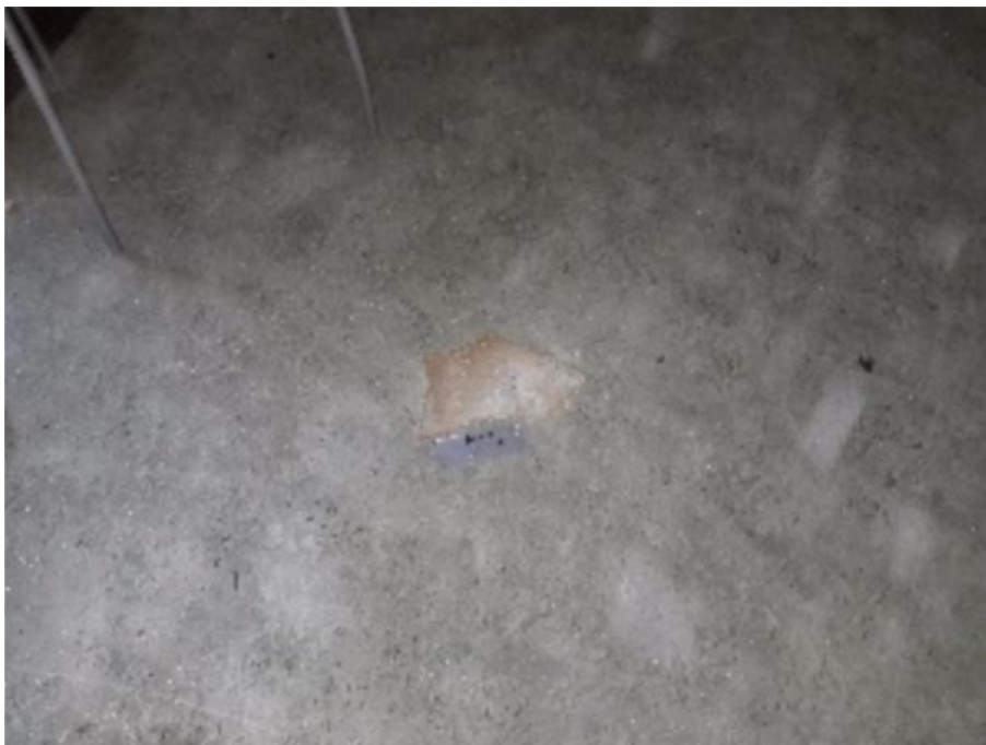
Foto F01, cementvloer - Lokaal 4
