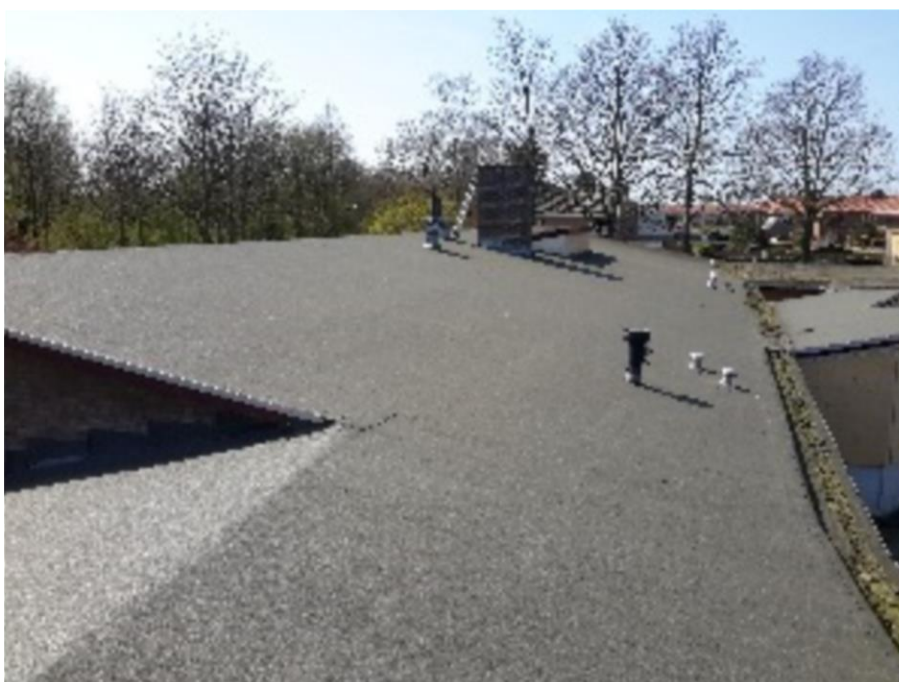
Foto F06, dakbitumen - Dak
