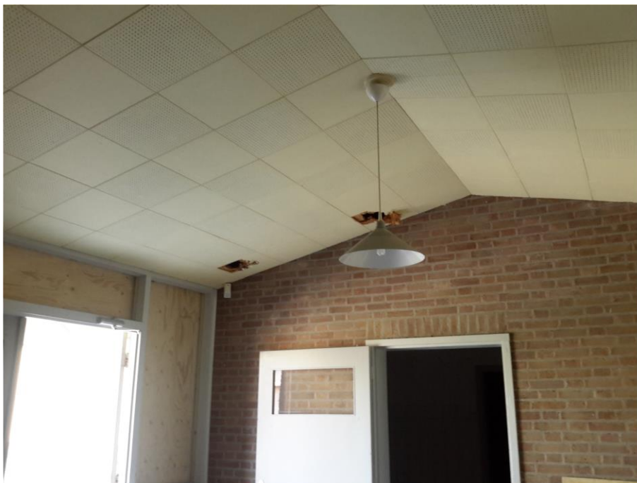
Foto F08, bitumen stelplaatjes - Plafond gehele ombouw
