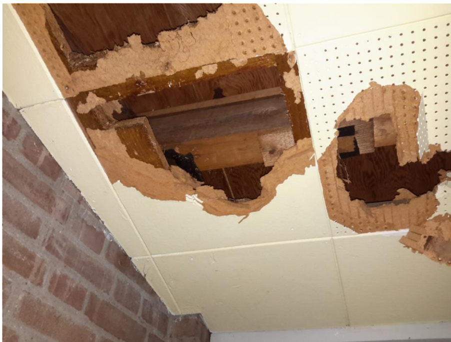
Foto F07, bitumen stelplaatjes - Plafond gehele ombouw
