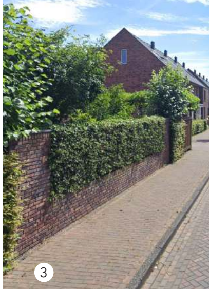
Metselwerk + beplanting (eindsituatie)
