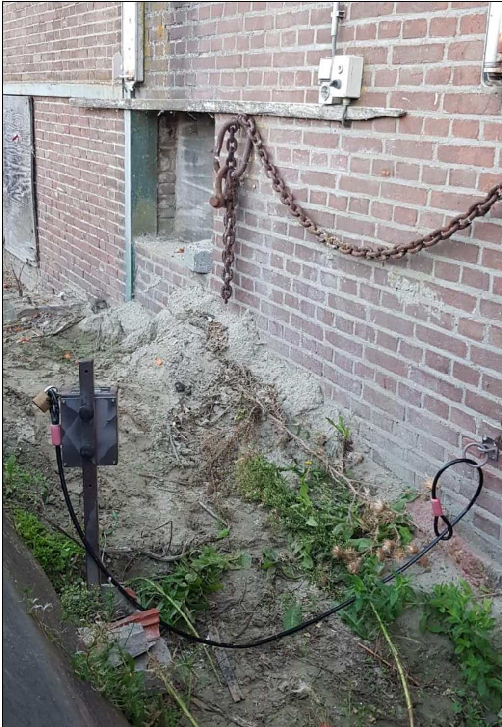
Foto 1: Geplaatste camera voor een opening in de gasfabriek.
