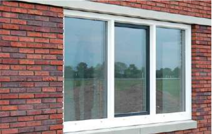
Betonaccenten t.p.v. kozijnen
