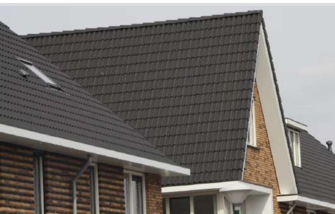
Traditionele dakpannen met mastgoot/overstek
