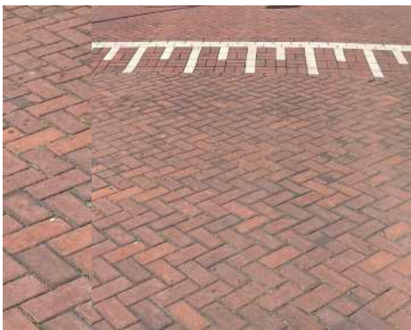
RIJBAAN Roodbruine klinkers gelegd in Keperverband.
