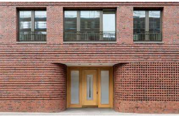
Reliëf en metselwerkpatronen om schaal te verkleinen
