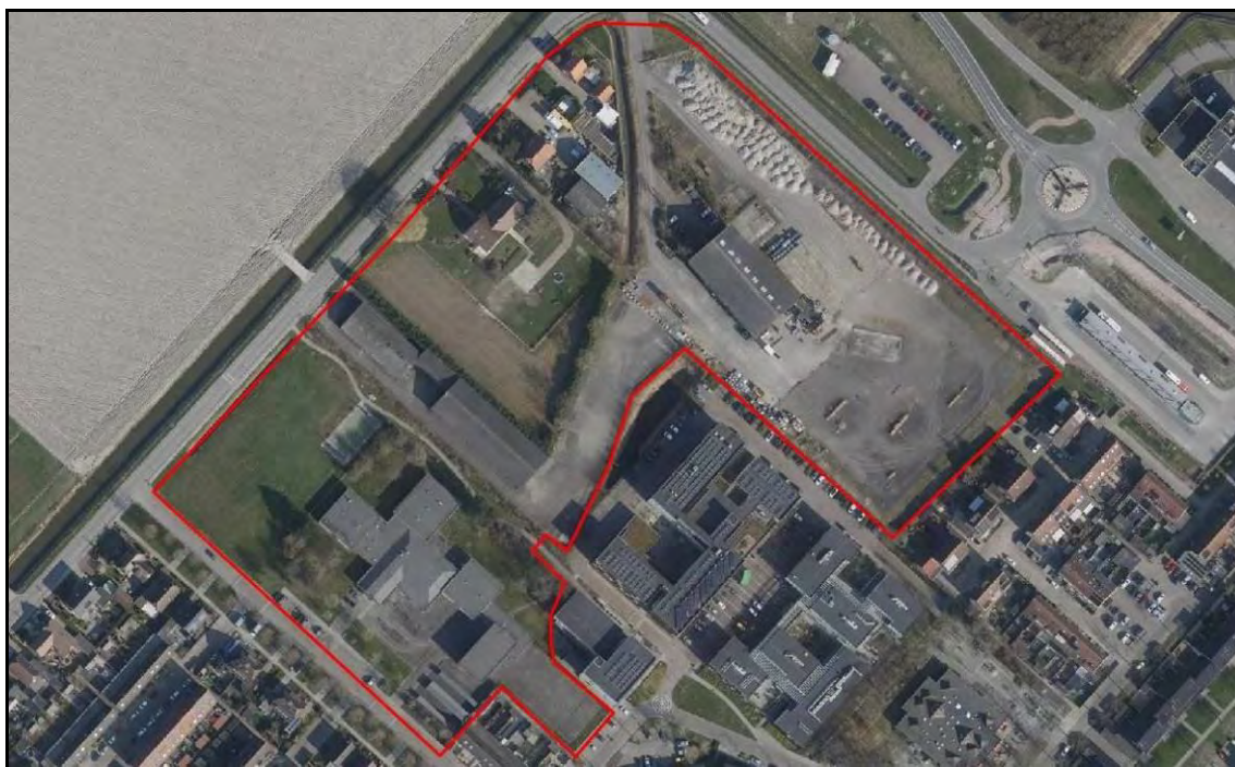
Afbeelding 2: Luchtfoto huidige situatie
