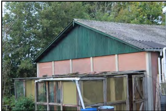
Afbeelding 6: Ruimte achter gevelbetimmering
