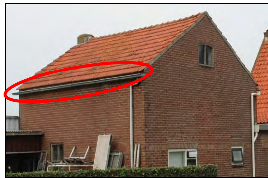
Afbeelding 17: Dakgoot met potentiële ruimte
