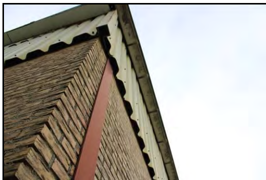
Afbeelding 4: Ruimte achter metalen golfplaten
