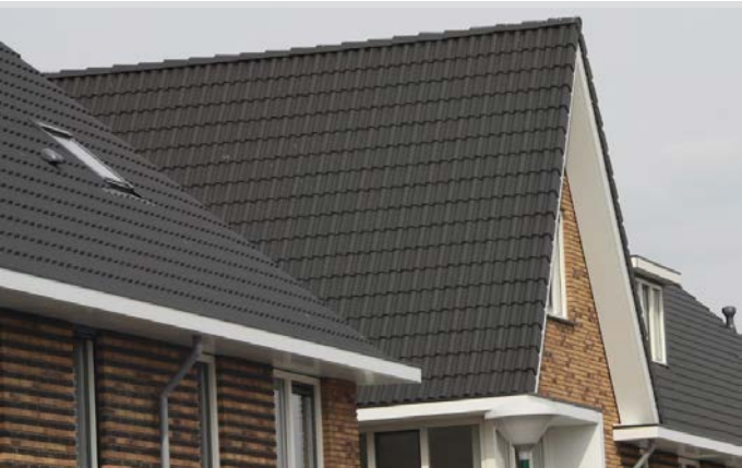
raditionele dakpannen met mastgoot/overstek
