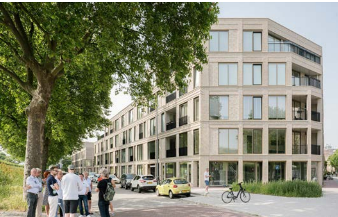
Balkons in vormtaal onderdeel van Monoliet
