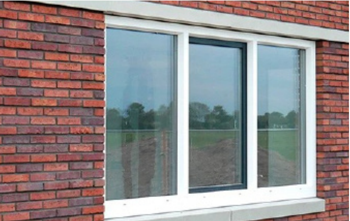
Betonaccenten t.p.v. kozijnen
