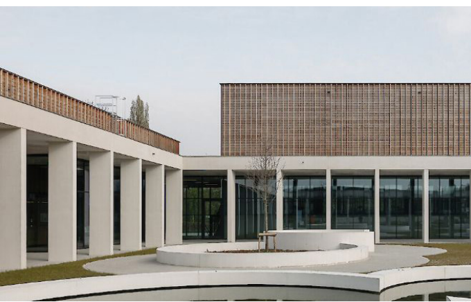
Betonnaccenten t.p.v. entree's garage en maatschappelijke functie
