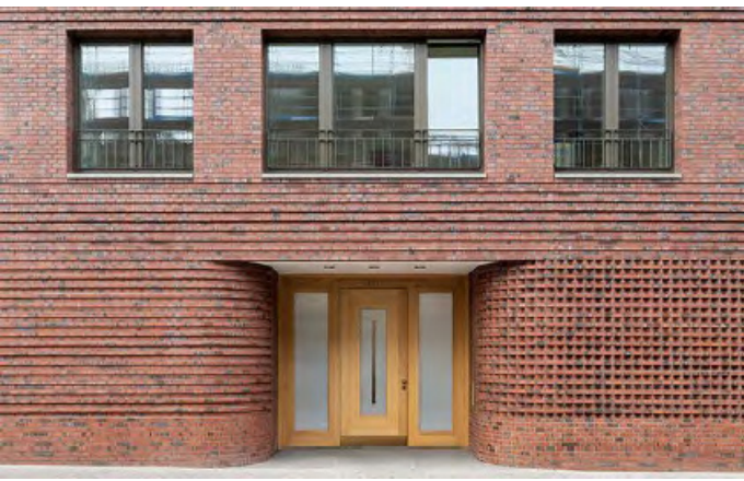
Reliëf en metselwerkpatronen om schaal te verkleinen
