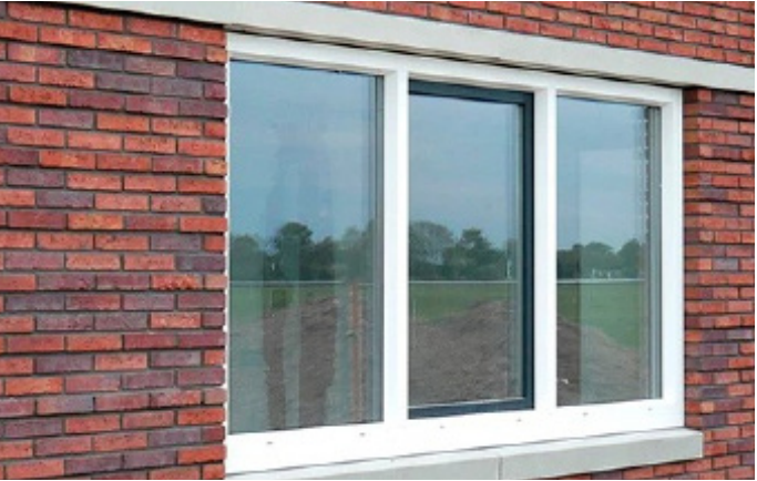
Betonaccenten t.p.v. kozijnen
