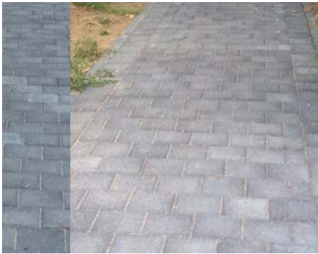
VOETPAD Betontegels met natuursteentoplaag, kleur antraciet
