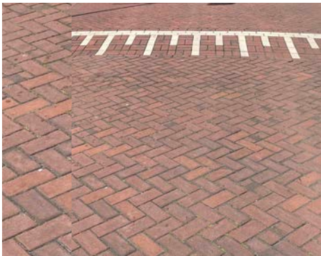
RIJBAAN Roodbruine klinkers gelegd in Keperverband.
