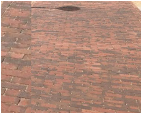
VOETPAD Roodbruine klinkers gelegd in Halfsteensverband.
