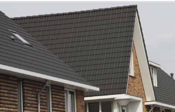
raditionele dakpannen met mastgoot/overstek
