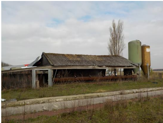
Foto 1. Bestaande stal met voersilo's
