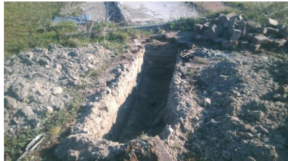
Foto 16. Asbestinspectiesleuf SL10
