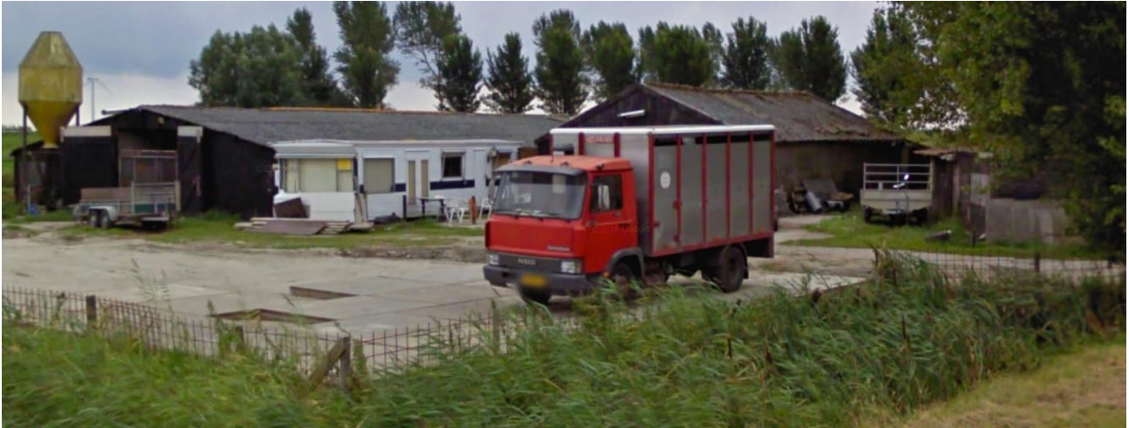
Foto 1. Oude foto van de situatie vóór de brand (Bron: opdrachtgever)
