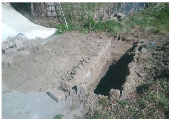
Foto 7. Asbestinspectiesleuf SL01
