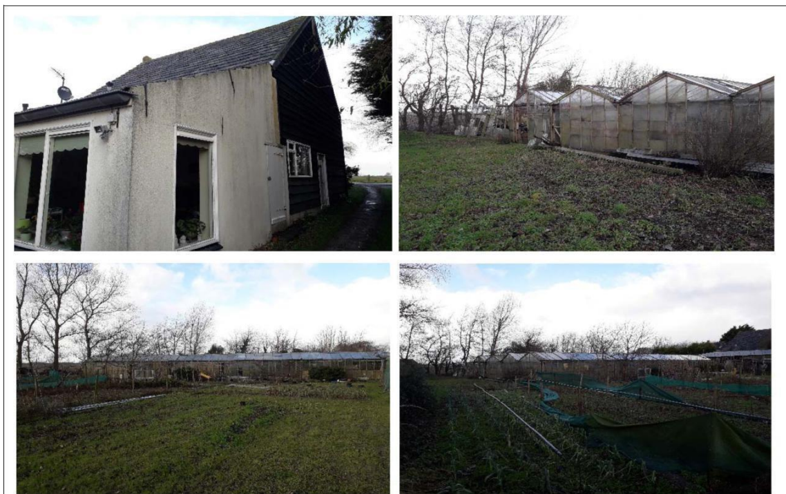
Figuur 4: foto's bestaande situatie
