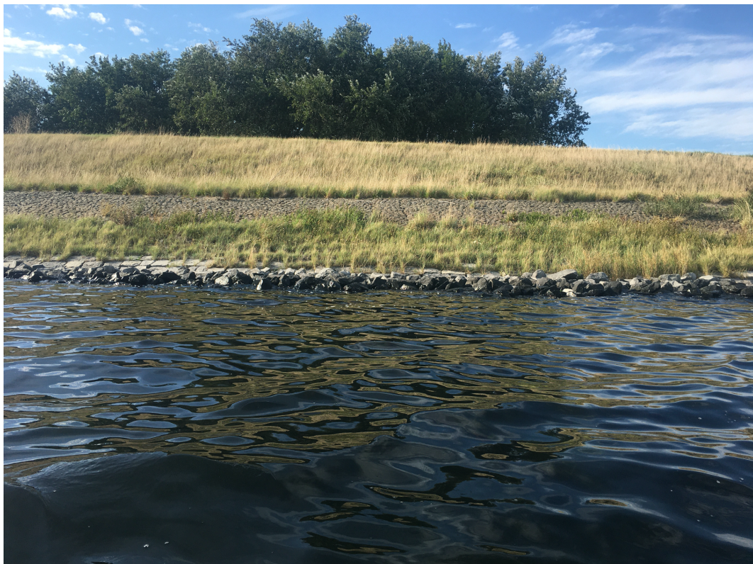
Figuur 2.2. De oever van de Grevelingen in het plangebied ongeveer ter hoogte van dwarsprofiel DP-30. Op de oever is de steenbestorting te zien waarop de tijdelijke werkstrook wordt aangelegd.
