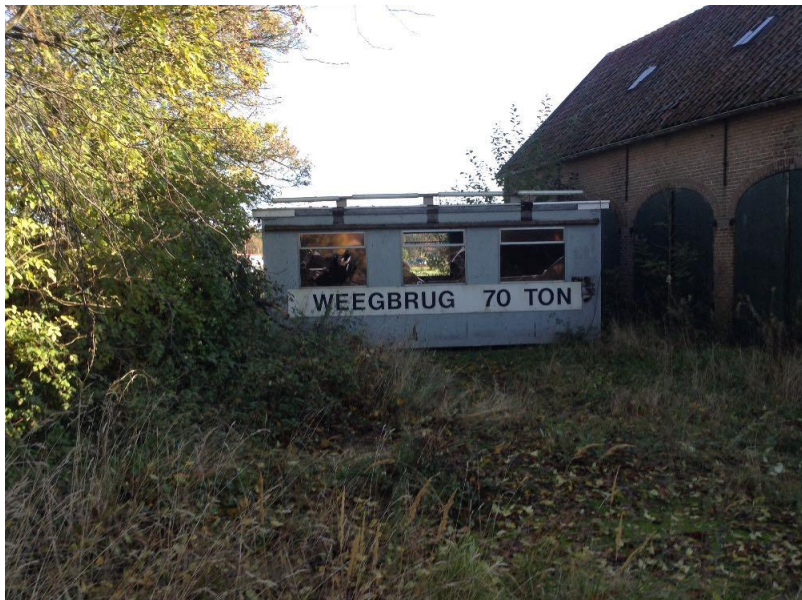
Weegbrug tbv voormalige gronddepot
