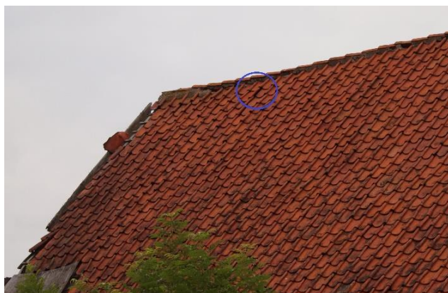
Figuur 7. Gierzwaluwnest onder de nok aan de westkant van de grote schuur
