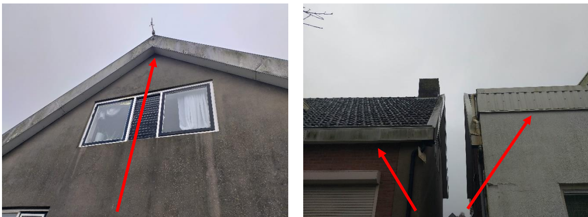
Figuur 5.1. Foto links aanzicht kopgevel woning Broekweg 23 (mogelijk ruimtes voor vleermuizen bij rode pijl), foto rechts aanzicht kopgevels en overstek.
