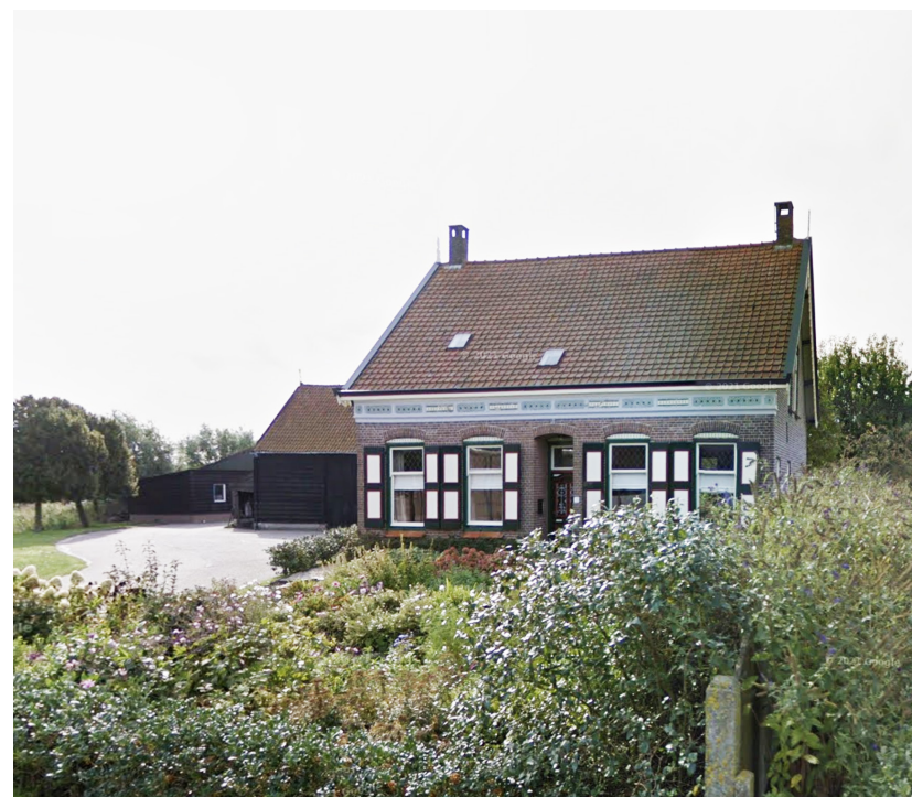
google streetview - schuur in de 2e lijn
