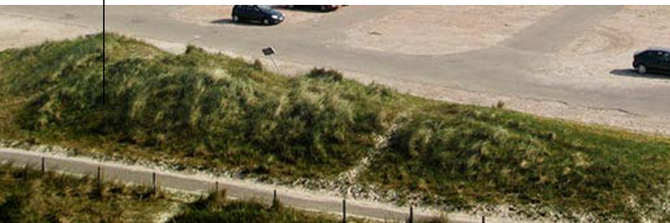
Aanleg 'duin' tussen parkeren en Vrijheidsweg
