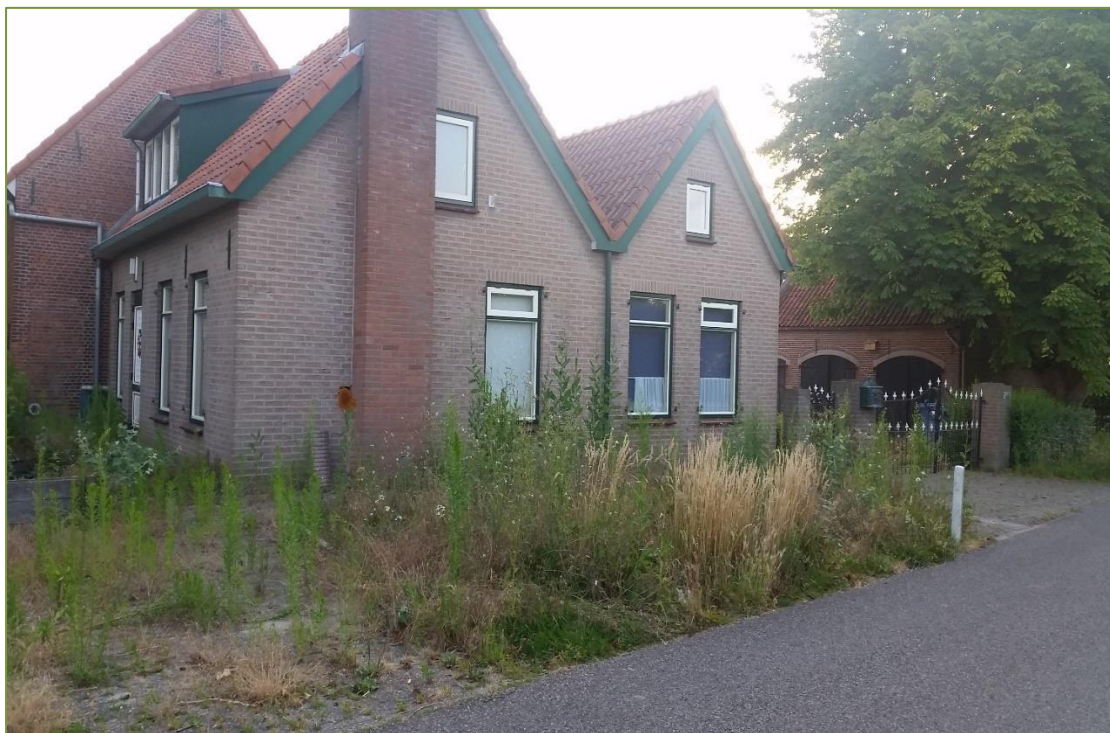
Foto 1: Te slopen woning aan de Kelderweg 1.
