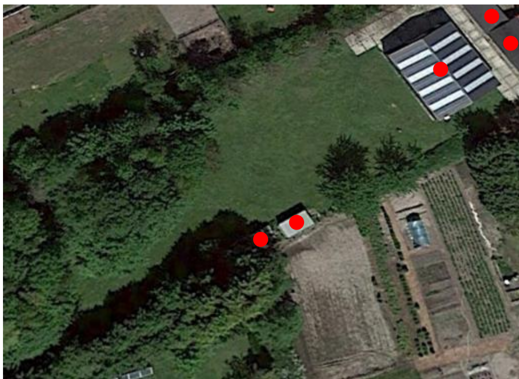
Kaart 3: Locatie Kelderweg 1, aansluitend aan het erf. De gebouwen met rode stip worden gesloopt.
