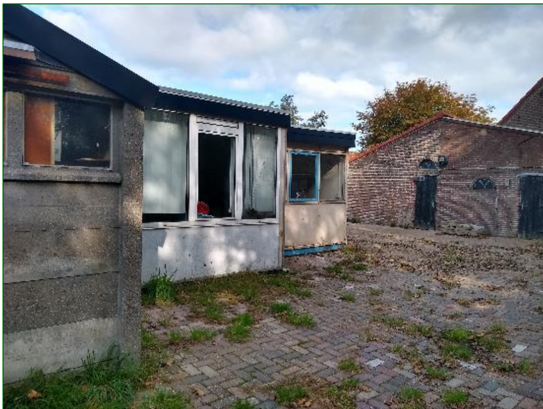
Foto 3: De te verwijderen en te slopen opstallen aan de Kelderweg 1.
