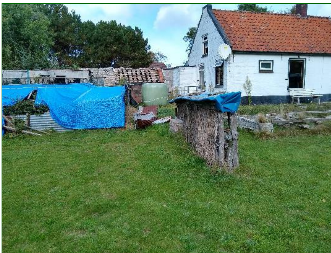
Foto 6: Te slopen woning en te verwijderen opstallen aan kelderweg 25.
