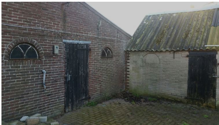
Afbeelding 2 | Sloop huidige bebouwing Kelderweg 1 (Bron: initiatiefnemer)
