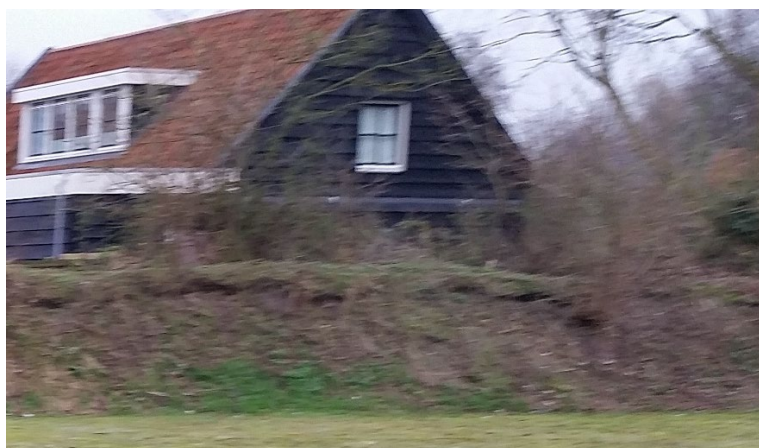
Afbeelding 31 | Locatie Kelderweg 25, zandwal no. 5 (Bron: Initiatiefnemer)
