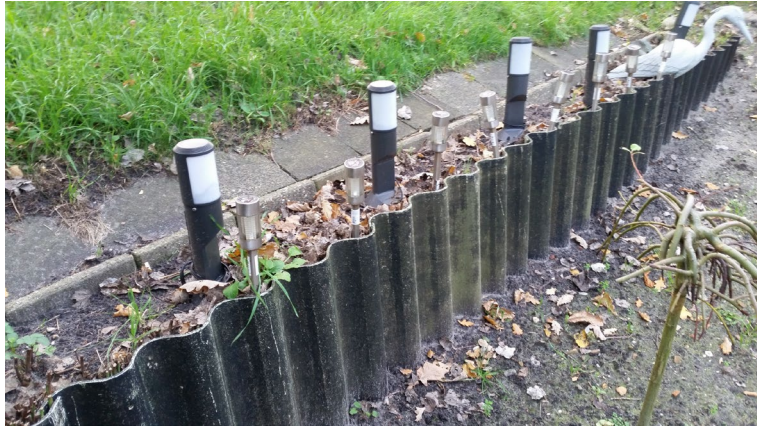
Afbeelding 4 | Huidige situatie asbestplaten en schurveling ingegraven plangebied (Bron: initiatiefnemer)
