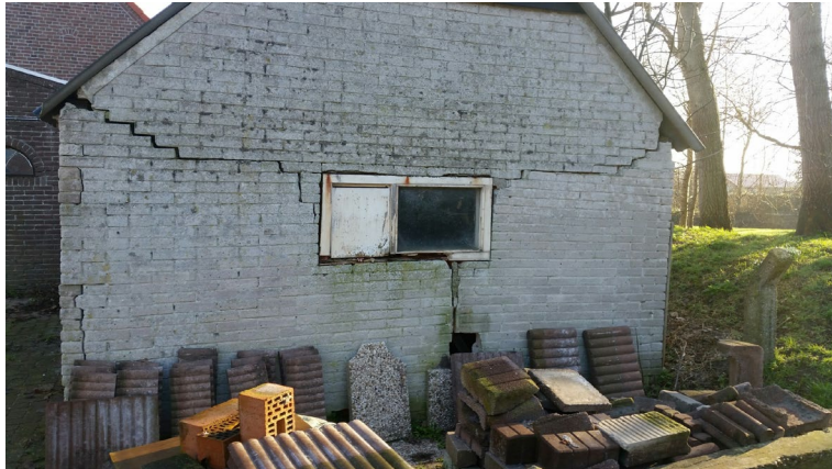
Afbeelding 1 | Sloop huidige bebouwing Kelderweg 1 (Bron: initiatiefnemer)
