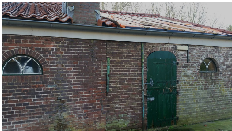
Afbeelding 3 | Sloop huidige bebouwing Kelderweg 1 (Bron: initiatiefnemer)
