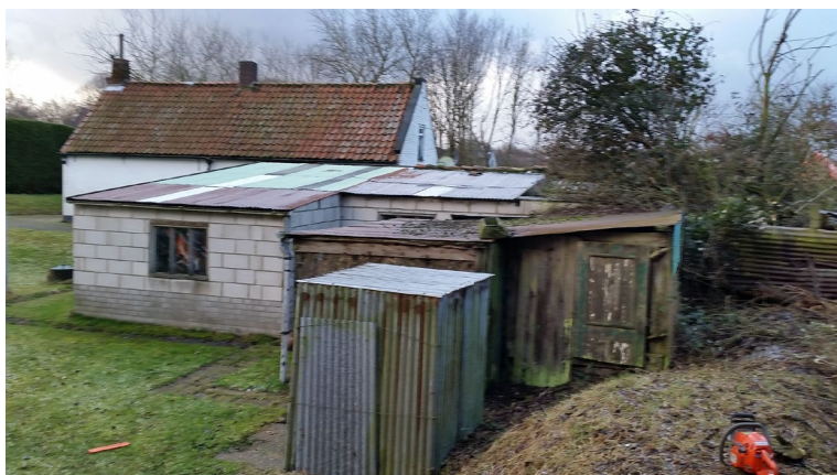
Afbeelding 20 | Locatie Kelderweg 25, verwijderen van houtopstanden 2018 (Bron: Initiatiefnemer)
