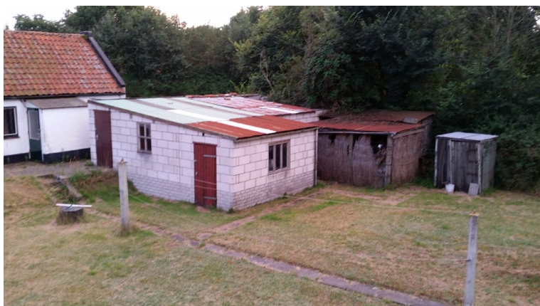
Afbeelding 21 | Locatie Kelderweg 25, verpauperde gebouwen 2017 (Bron: Initiatiefnemer)
