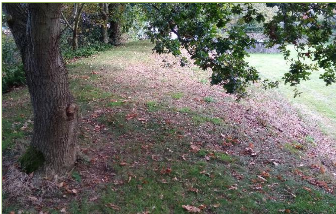
Foto 13: laag hangende takken van bomen en struiken geven te veel schaduw en kunnen de zandwal beschadigen.
