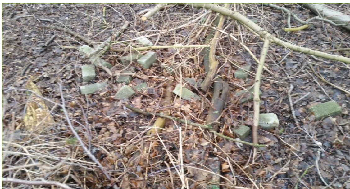
Foto 2: slooppuin en ander afval op perceel voor de sanering 2015-2017.
