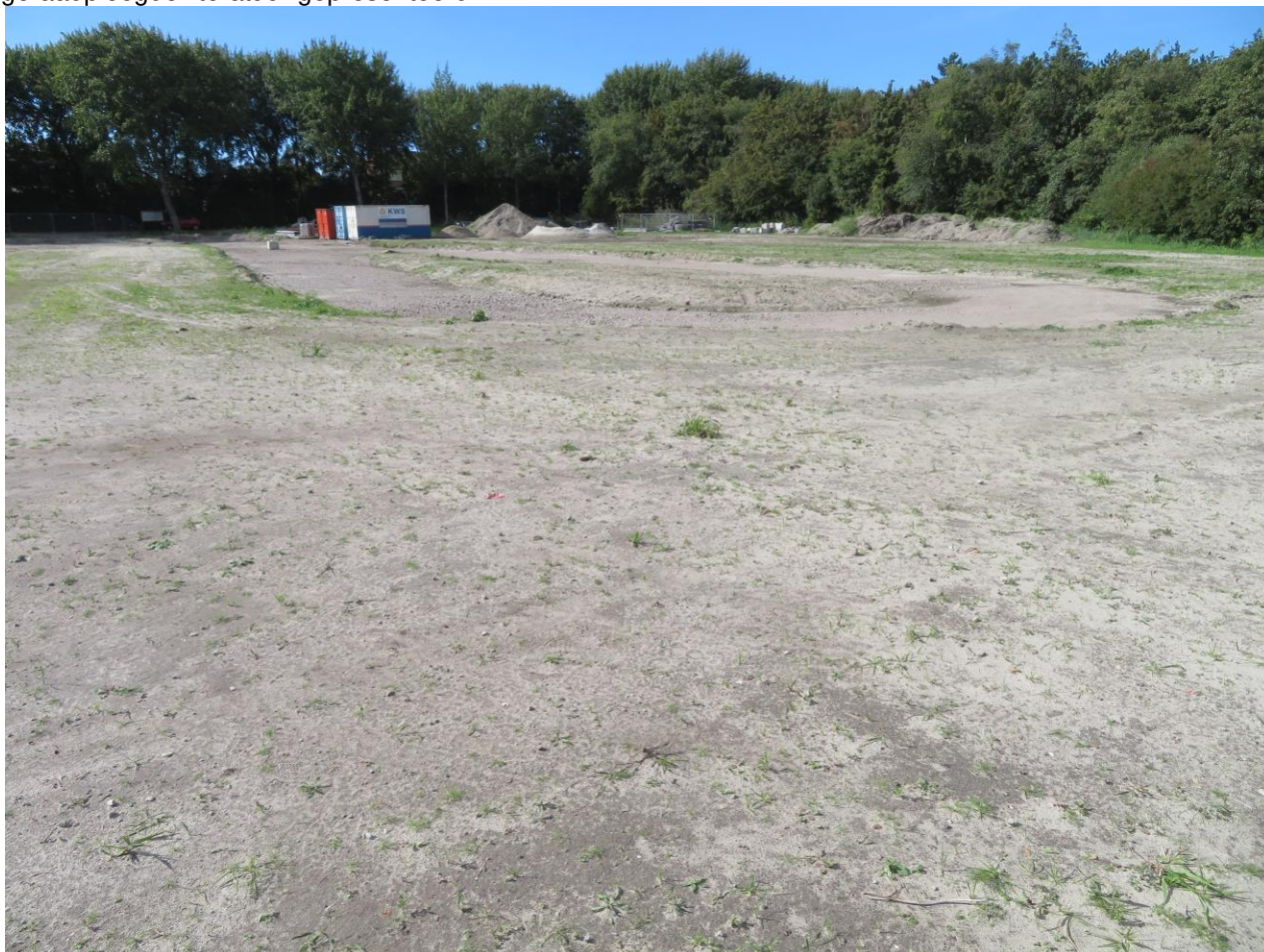
Gedeeltelijk aanzicht plangebied: braakliggend en bouwrijp met de contouren van de weg reeds zichtbaar.
