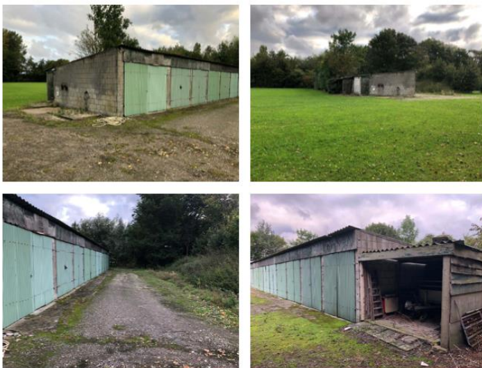
Figuur 2.2: foto bestaande bebouwing
