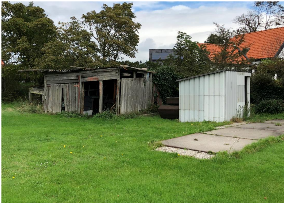
Figuur 4 | Te slopen bouwwerken (bron: initiatiefnemer)
