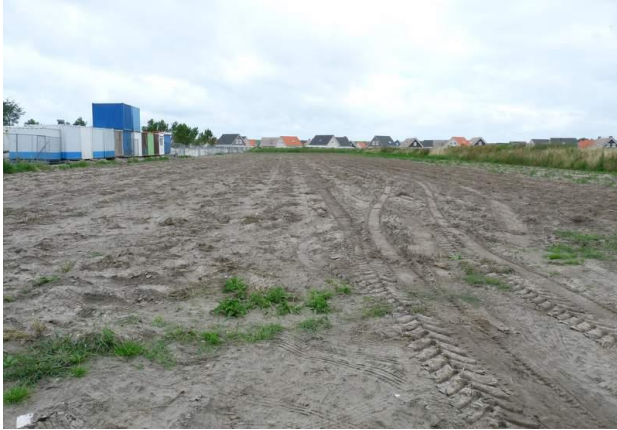
Fig. 4.3. Overzicht plangebied, met links het in ontwikkeling zijnde gebied, en op de achtergrond de huisjes van het vakantiepark. Foto genomen richting het noorden.
