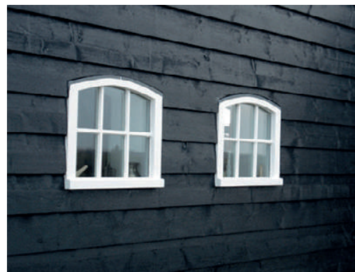
Figuur 17 | Gepotdekselde gevel
