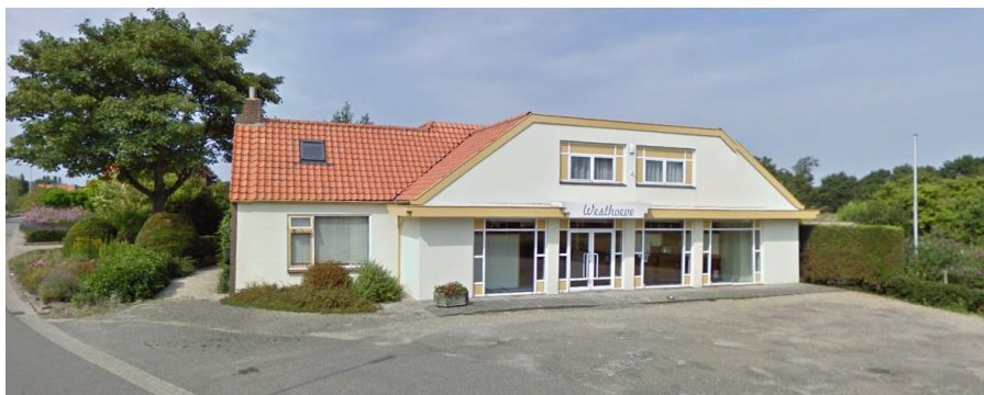
Figuur 1.2 foto gevel voormalige winkel
