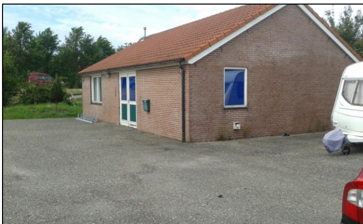
verenigingsgebouw gezien vanaf de achterzijde
