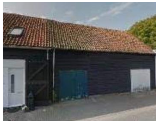
Figuur 2.2 foto inmiddels gesloopte schuur
