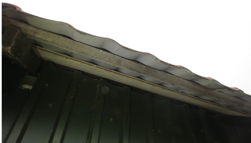
Afbeelding 6: Weergave van het dakvlak van de schuur met de stalen dakbeplating.
