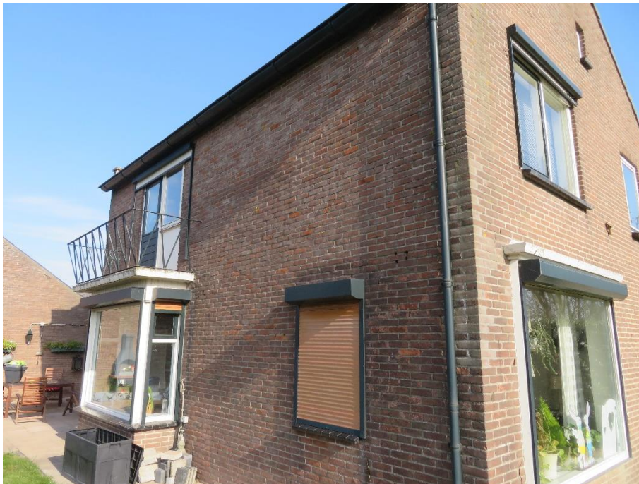
De stal (links) en het woonhuis hebben geen voor vleermuizen geschikte invliegopeningen.
