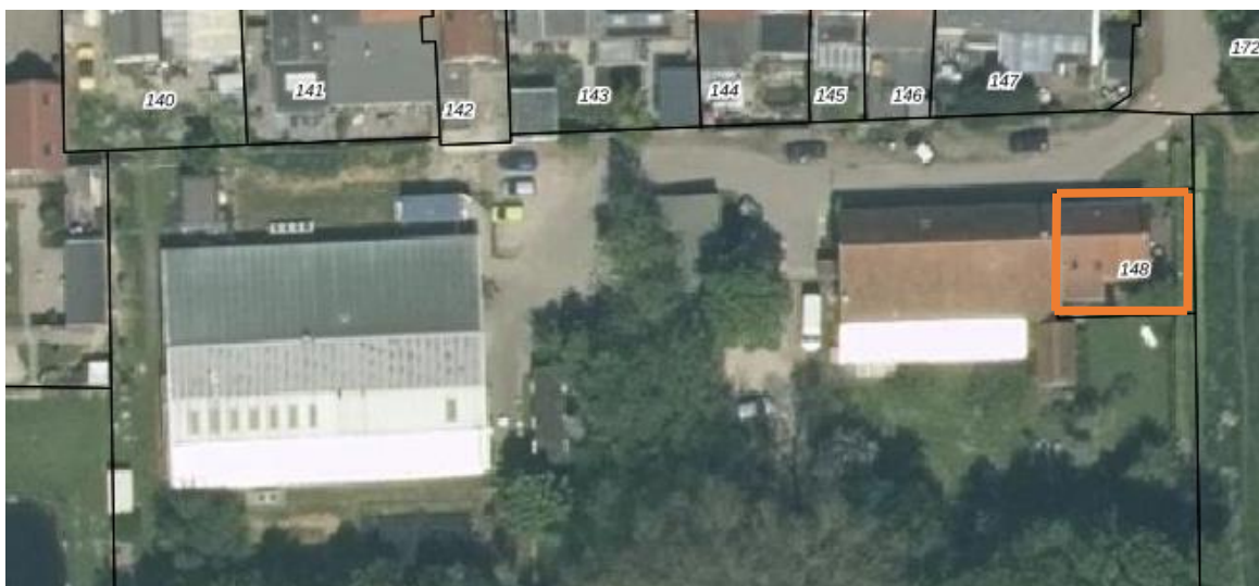
Figuur 1.2 plangebied (woning) met ten westen de bedrijfsbebouwing
