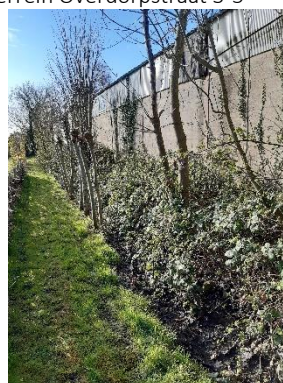
Foto 6: Gedempte sloot, achterzijde schuur
