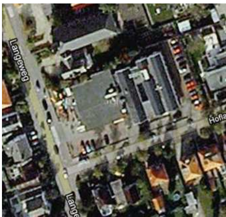
Luchtfoto huidige situatie
