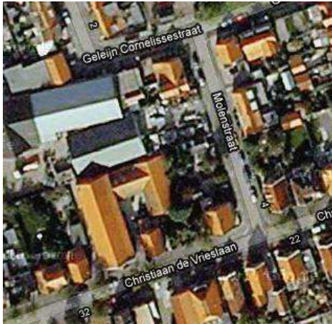
Luchtfoto huidige situatie
