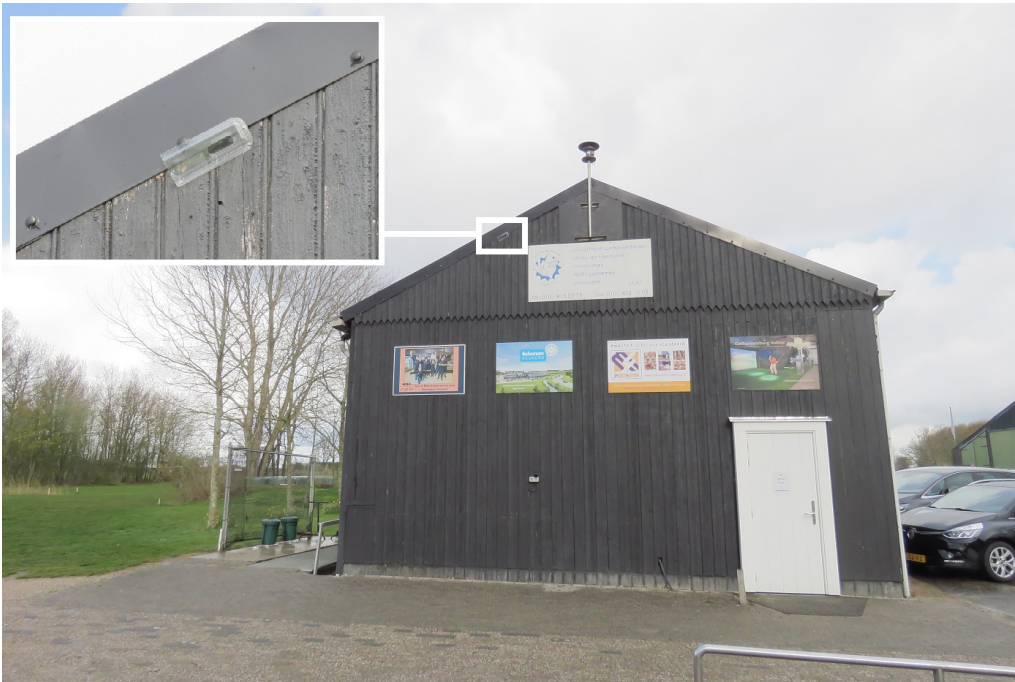
Afbeelding 5: De exclusionflap, geplaatst op opening aan de zuidoostelijke gevel.
