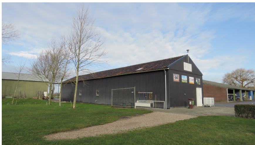
Afbeelding 2: De te slopen loods, kijkrichting noord
