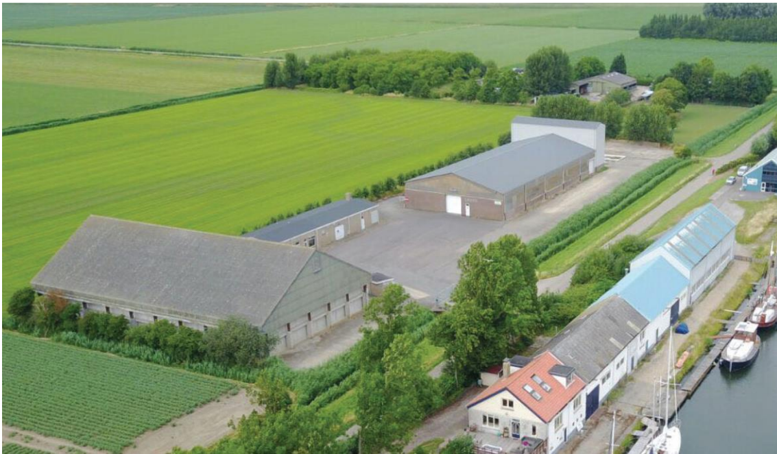
Afbeelding 2.1: Luchtfoto bestaande situatie
