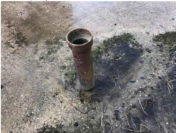
Gebouw C, metaal
