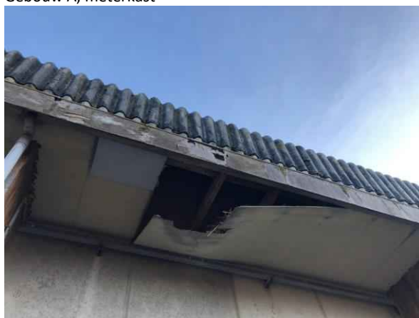
Gebouw A, overzicht
