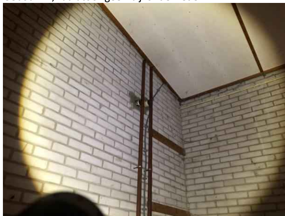
Gebouw B, leidingen metaal isolatie niet verdacht
