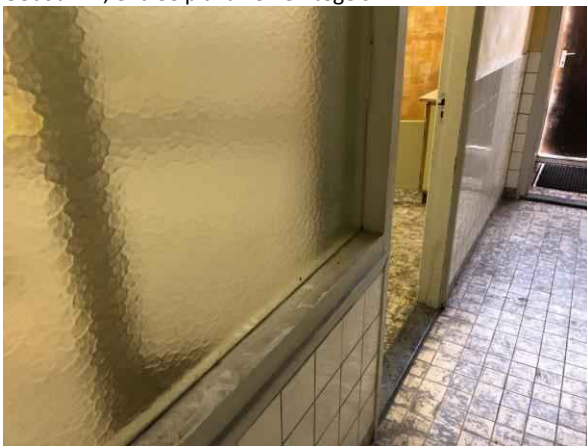
Gebouw B, entree enkel glas
