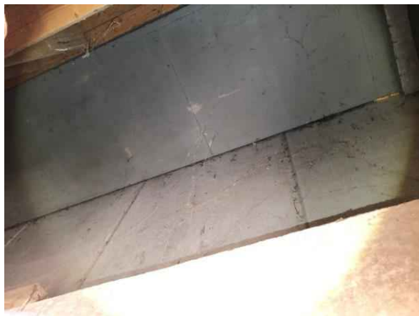
Gebouw A, meterkast
