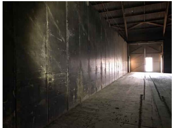
Gebouw A, overzicht
