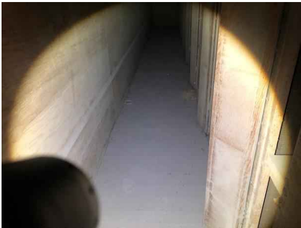
Gebouw C, hout
