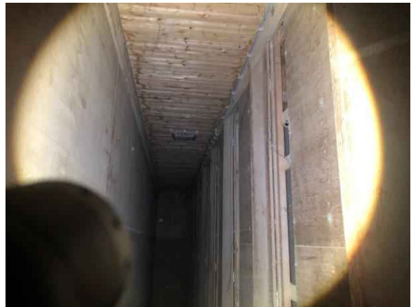
Gebouw C, hout
