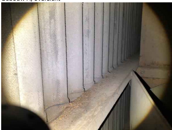
Gebouw A, overzicht
