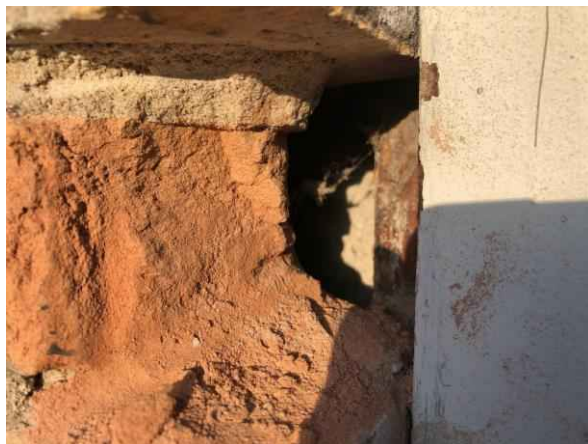
Gebouw B, spouw geen bijzonderheden
