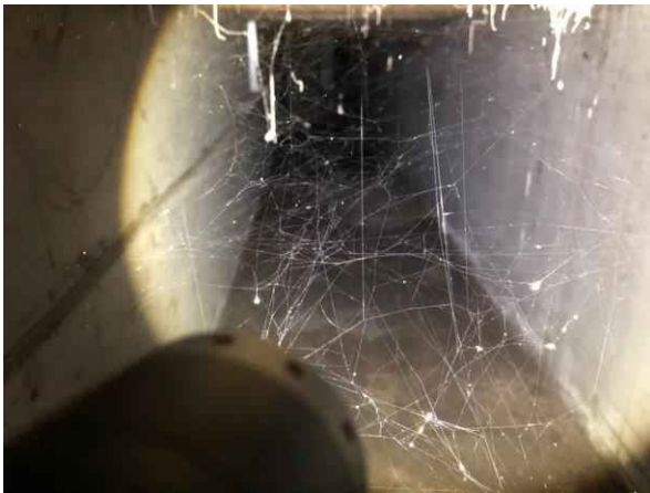
Gebouw C, kruipruimte
