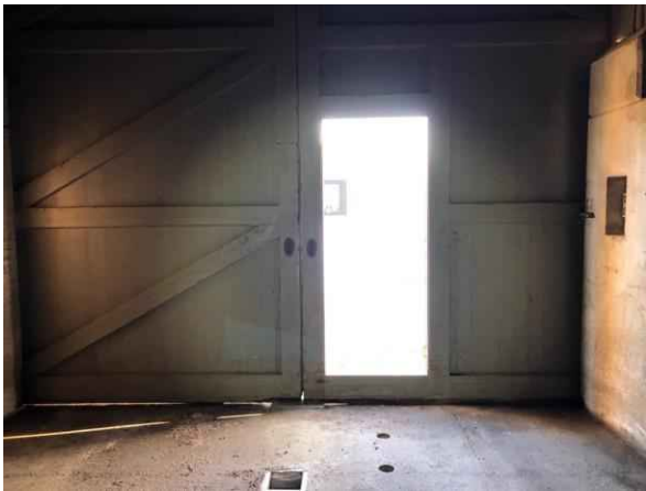
Gebouw A, overzicht
