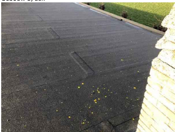
Gebouw B, dak
