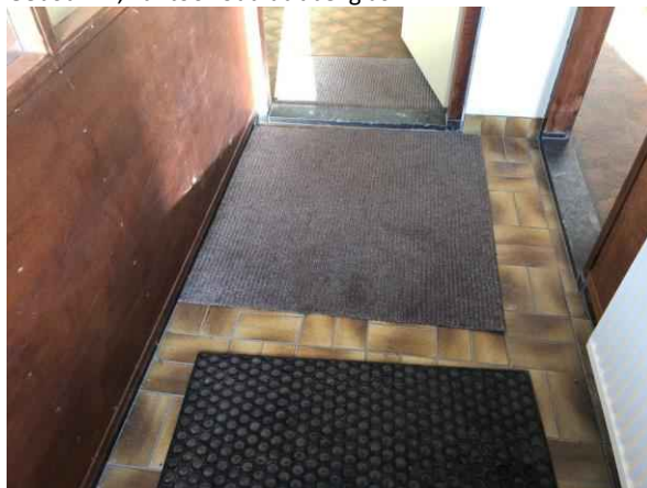
Gebouw B, entree plavuizen
