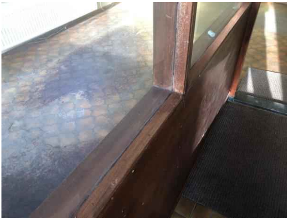
Gebouw B, entree enkel glas
