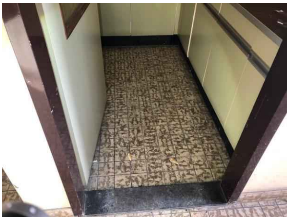
Gebouw B, keuken plavuizen en tegels
