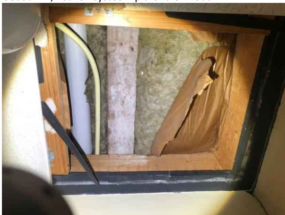
Gebouw B, toiletten boven systeem plafond
