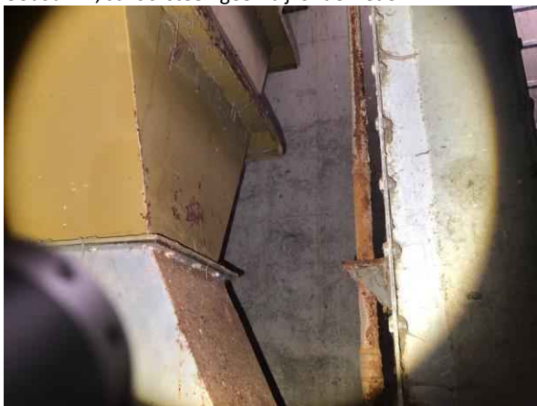
Put naast gebouw A, beton
