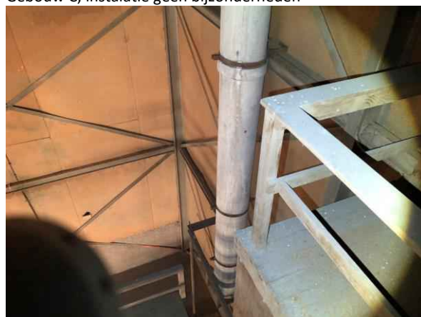
Gebouw C, buis
