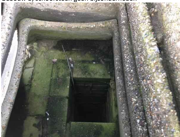
Gebouw B, schoorsteen geen bijzonderheden
