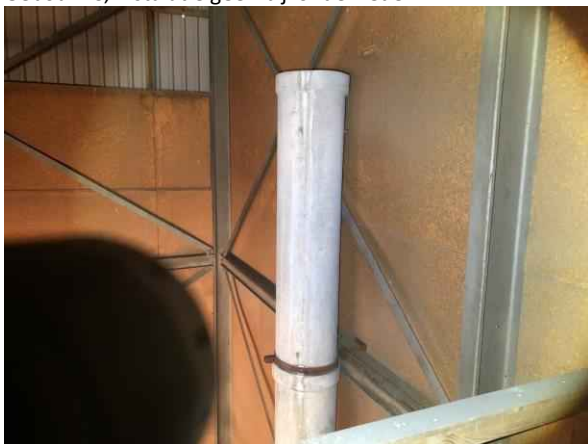
Gebouw C, buis
