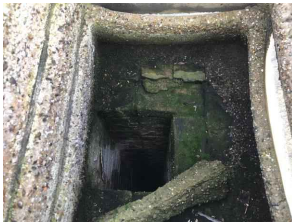
Gebouw B, schoorsteen geen bijzonderheden
