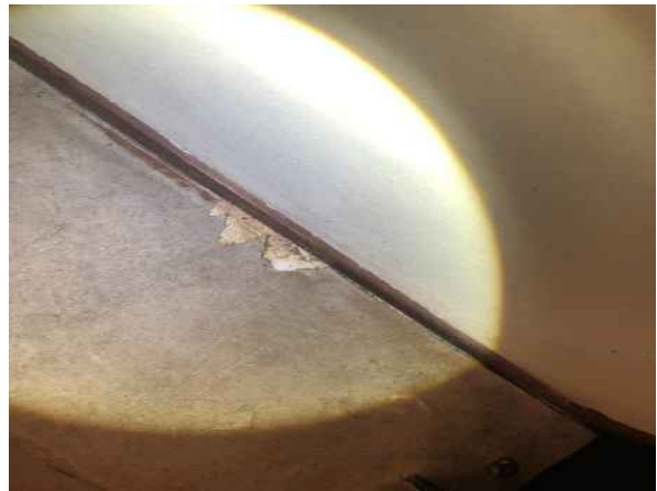
Gebouw B, opslag linoleum en beton
