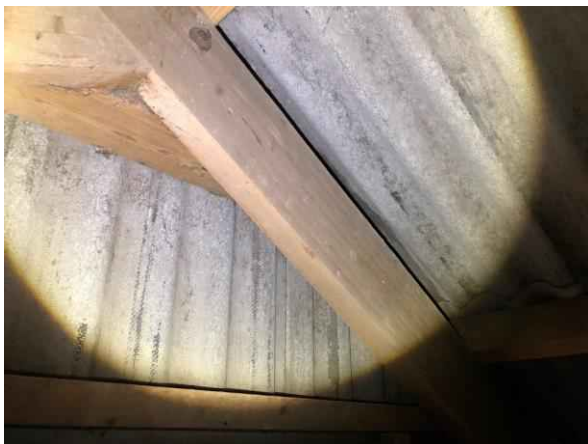
Gebouw A, overzicht
