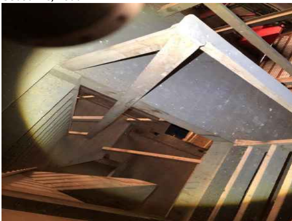
Gebouw C, hout
