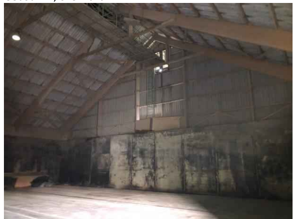
Gebouw A, overzicht
