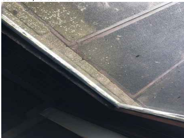
Gebouw B, entree enkel glas
