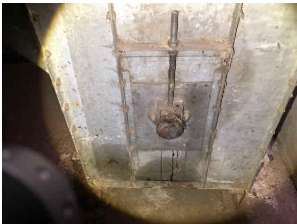
Put naast gebouw A, metaal geen bijzonderheden
