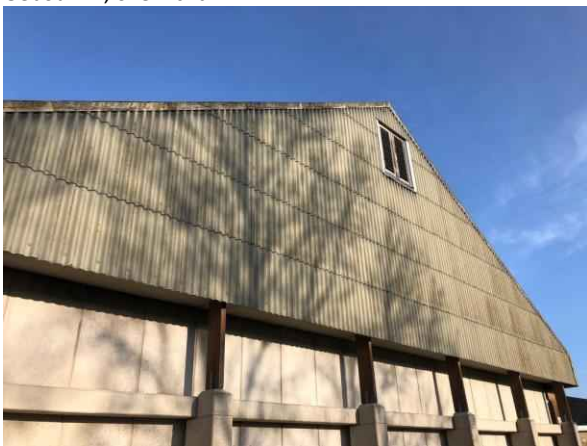
Gebouw A, overzicht
