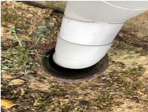
Gebouw C, metaal
