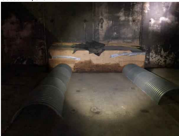
Gebouw A, overzicht
