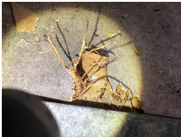
Gebouw B, berging linoleum en beton
