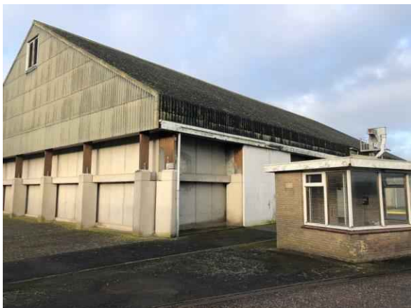
Gebouw A, overzicht
