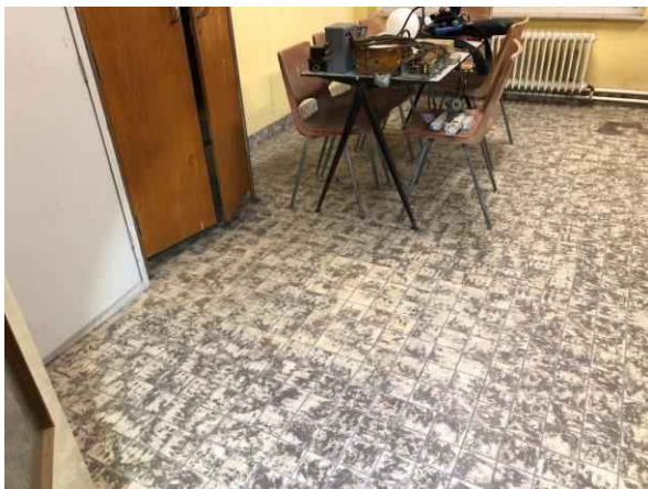
Gebouw B, kantine plavuizen
