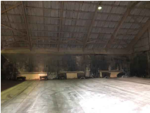
Gebouw A, overzicht
