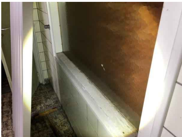
Gebouw B, wasruimte enkel glas
