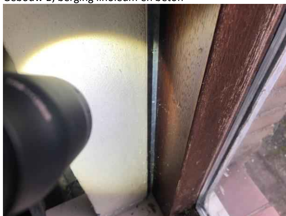
Gebouw B, berging metaal
