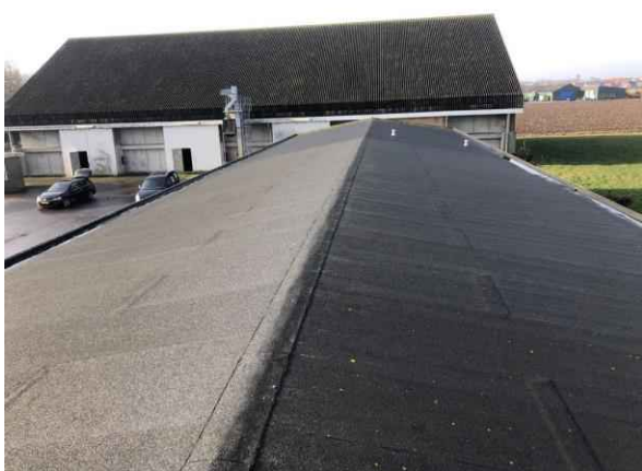
Gebouw B, dak
