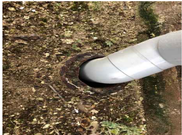
Gebouw C, metaal
