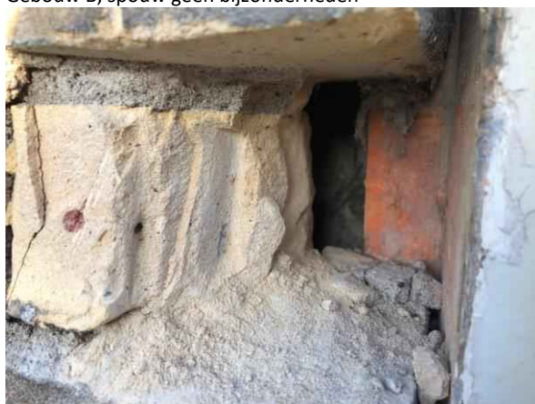
Gebouw B, spouw geen bijzonderheden
