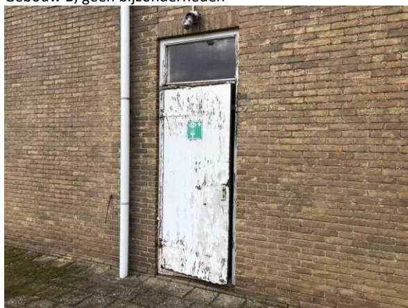
Gebouw B, entree
