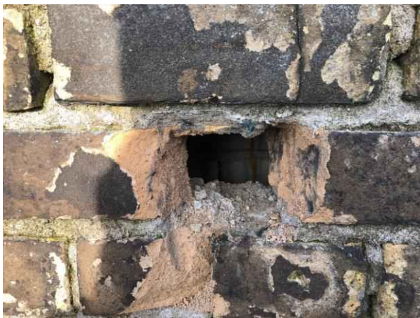
Gebouw B, schoorsteen geen bijzonderheden
