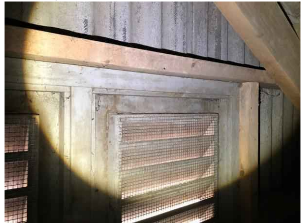
Gebouw A, overzicht
