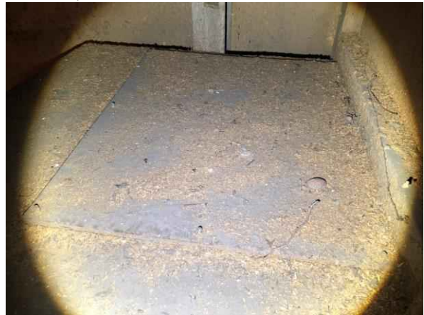
Gebouw C, hout
