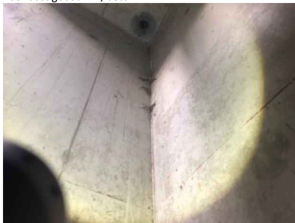
Put naast gebouw A, beton
