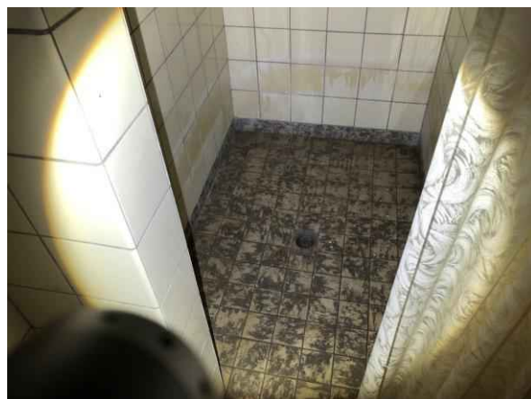
Gebouw B, wasruimte douche
