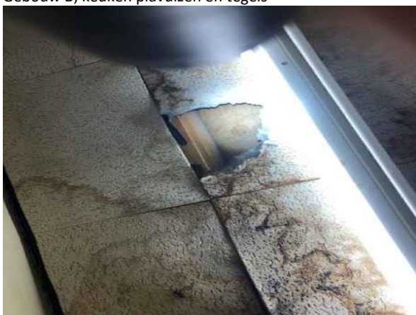
Gebouw B, keuken systeem plafond en hout
