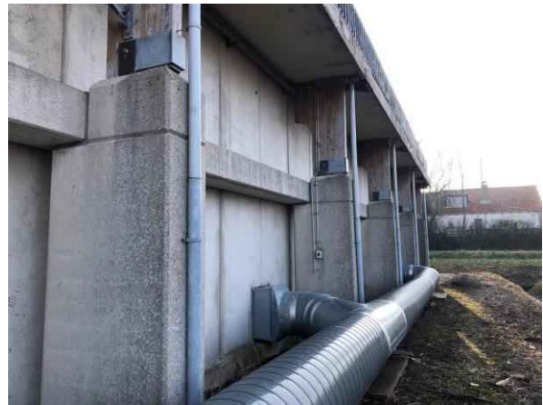
Gebouw A, overzicht
