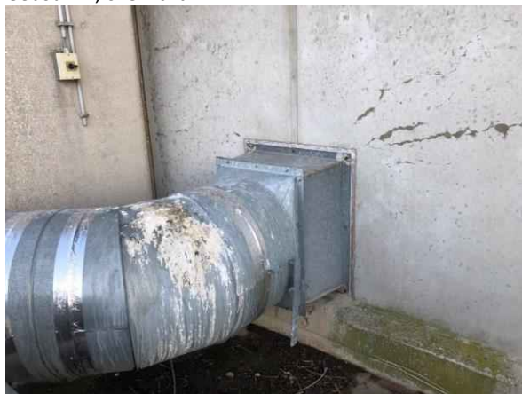
Gebouw A, overzicht
