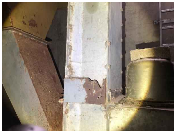
Put naast gebouw A, metaal geen bijzonderheden
