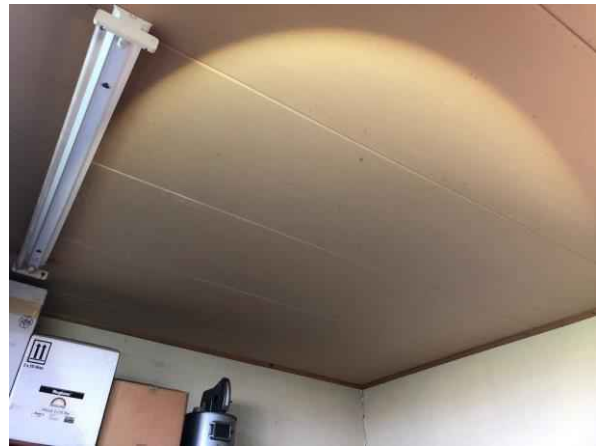
Gebouw B, opslag gips beplating
