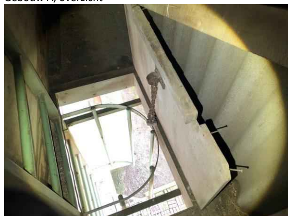
Gebouw A, overzicht
