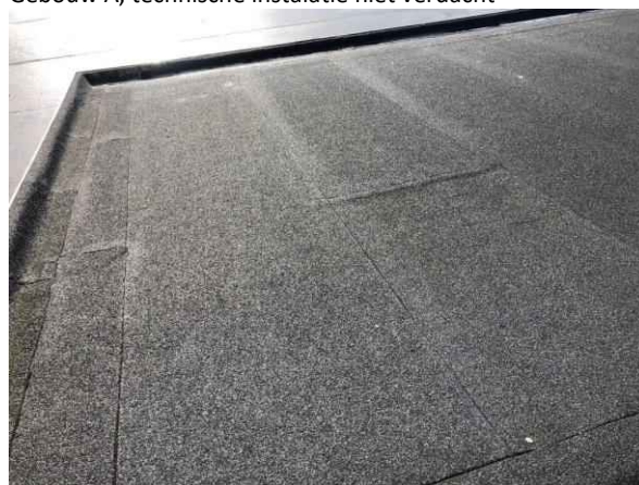
Gebouw B, dak
