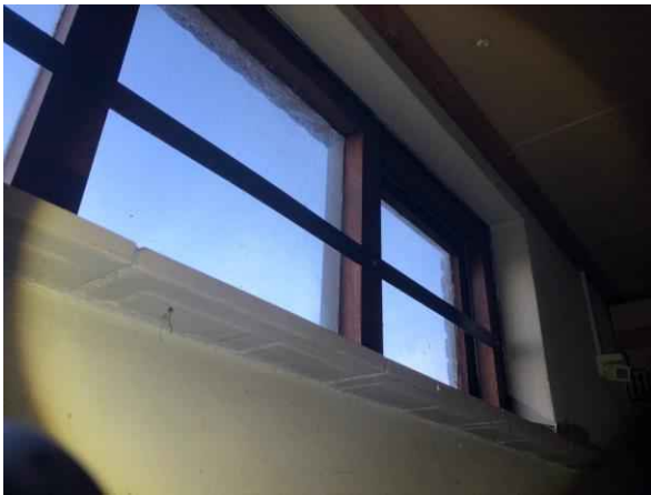
Gebouw B, opslag enkel glas
