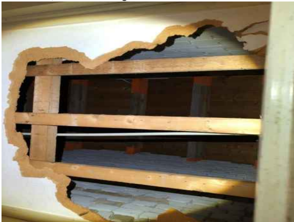
Gebouw B, entree boven systeem plafond
