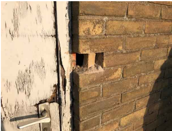
Gebouw B, spouw geen bijzonderheden
