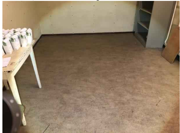
Gebouw B, opslag linoleum en beton
