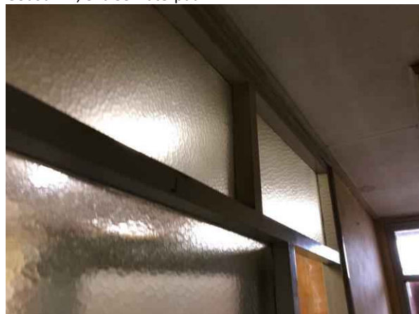
Gebouw B, entree enkel glas
