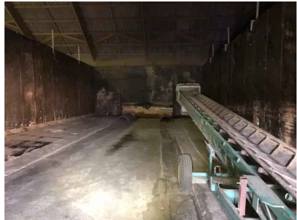
Gebouw A, overzicht
