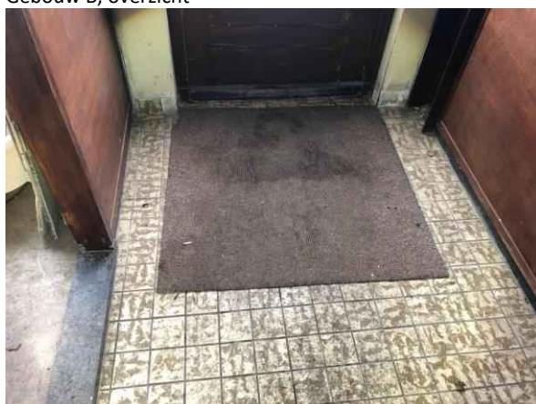
Gebouw B, entree plavuizen
