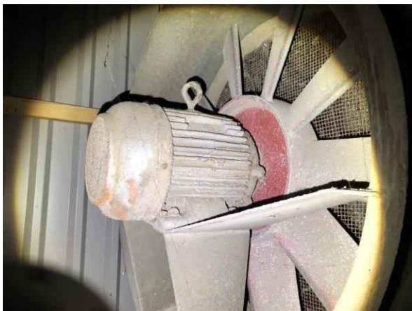
Gebouw C, geen bijzonderheden
