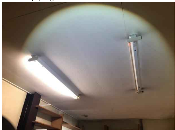
Gebouw B, opslag plafond beplating
