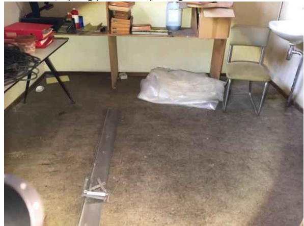
Gebouw B, opslag linoleum en beton
