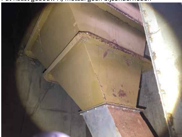
Put naast gebouw A, metaal geen bijzonderheden
