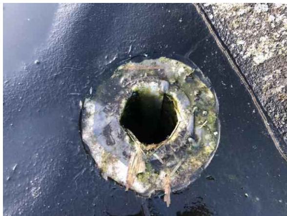
Weegstation, dak metaal
