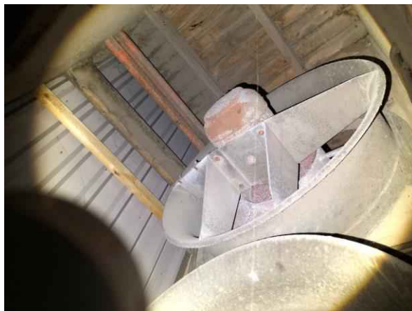
Gebouw C, geen bijzonderheden
