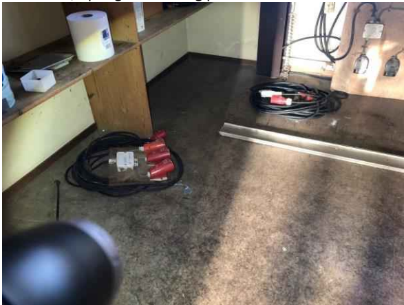
Gebouw B, opslag linoleum en beton
