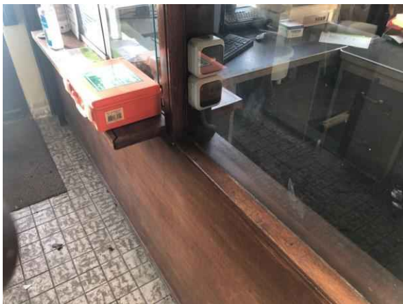
Gebouw B, kantoor enkel glas
