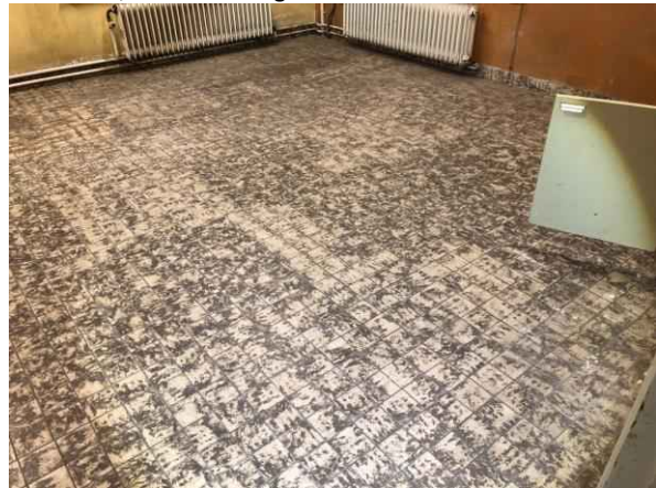
Gebouw B, kantine plavuizen
