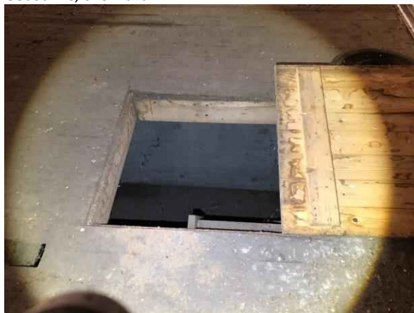
Gebouw C, kruipruimte
