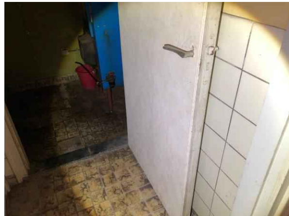
Gebouw B, technische ruimte beplating niet verdacht
