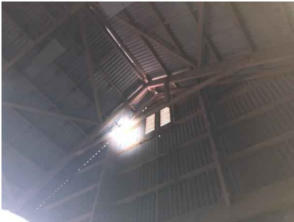
Gebouw A, overzicht
