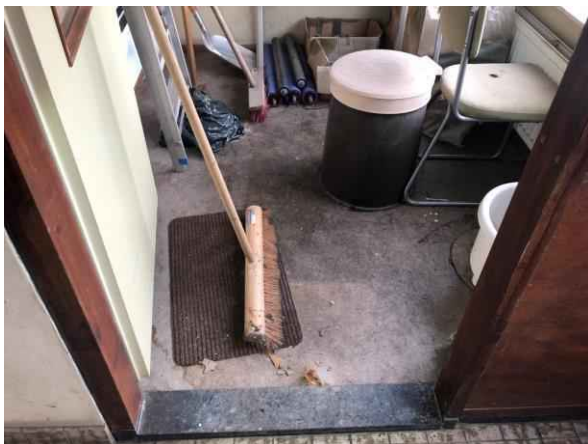
Gebouw B, berging linoleum en beton
