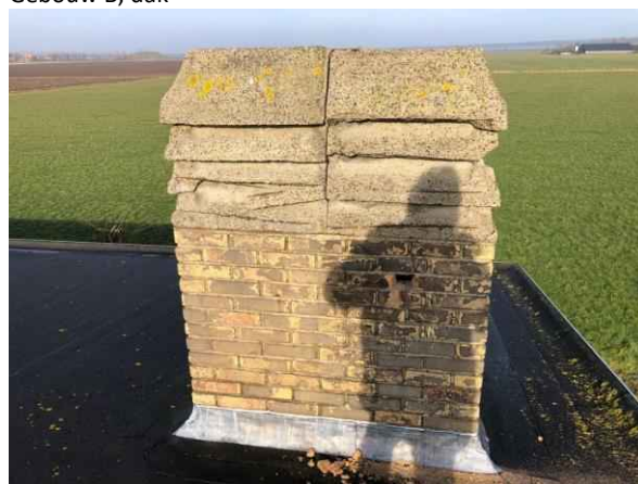
Gebouw B, schoorsteen geen bijzonderheden
