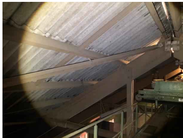
Gebouw A, overzicht
