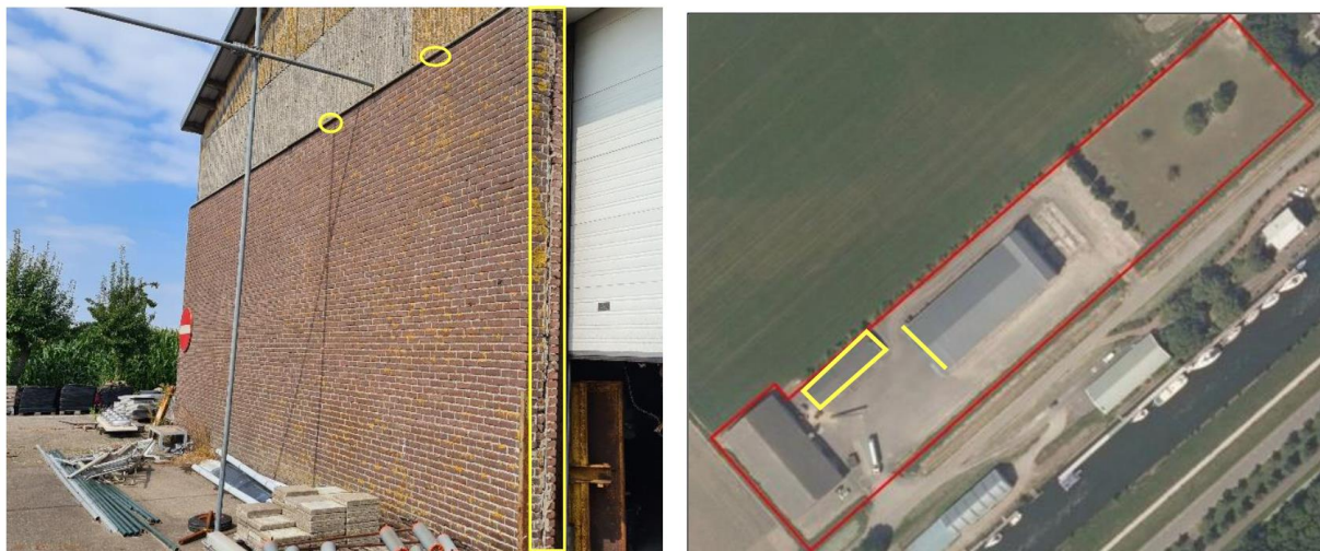
Figuur 7 Links: grote loods, enkele open stootvoegen en spouw met geel omlijnd. Rechts: rood omlijnd gebied = plangebied. Gele lijnen weergeven geschikte muren voor gebouw bewonende vleermuizen.
