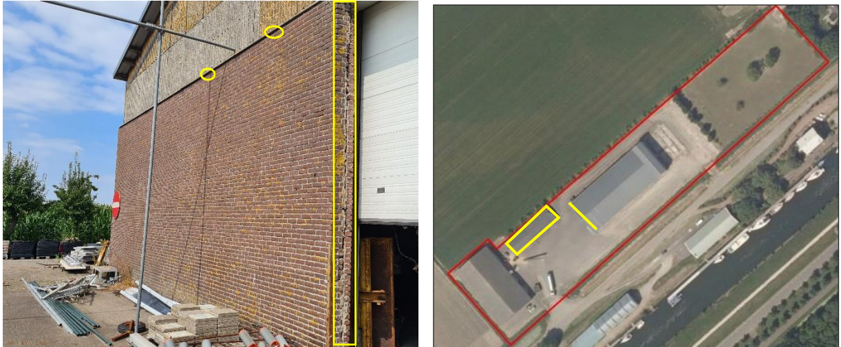
Figuur 7 Links: grote loods, enkele open stootvoegen en spouw met geel omlijnd. Rechts: rood omlijnd gebied = plangebied. Gele lijnen weergeven geschikte muren voor gebouw bewonende vleermuizen.
