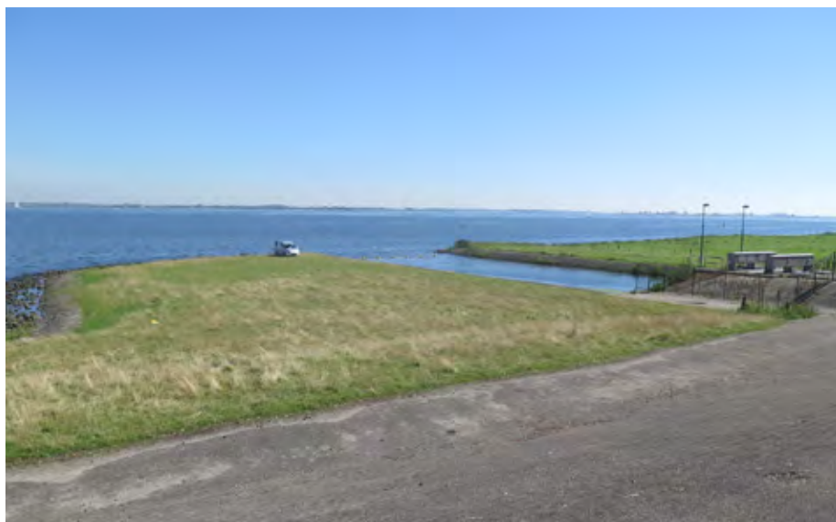
Gemaal Koert en het Haringvliet
