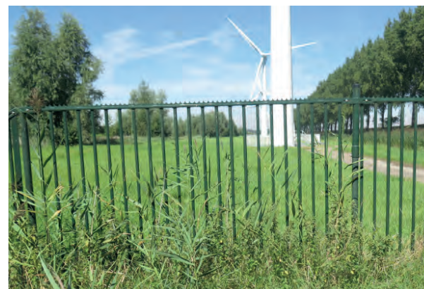
Referentie: hekwerk bij windturbines langs dijk
