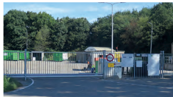
Referentie: hekwerk milieustraat Johannispolderseweg. Geen borden plaatsen
