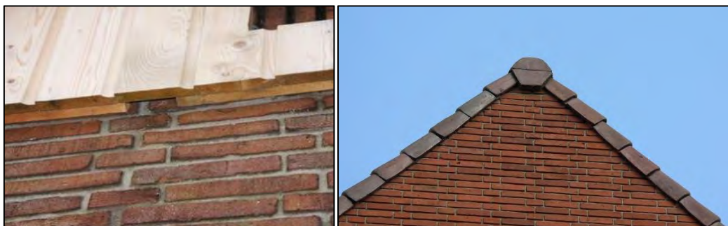
Figuur 14: Voorbeeld van toegankelijke boeiborden (links) en nokvorst (rechts) (Bron: bouwnatuurinclusief).
