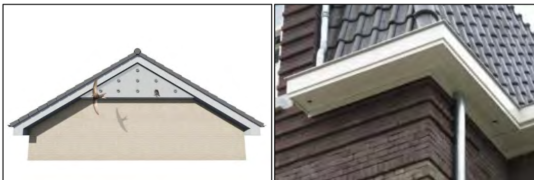
Figuur 17: Gevelbetimmering (links, bron Unitura) en nestgelegenheid in overstek (rechts, bron: checklist groen bouwen).
