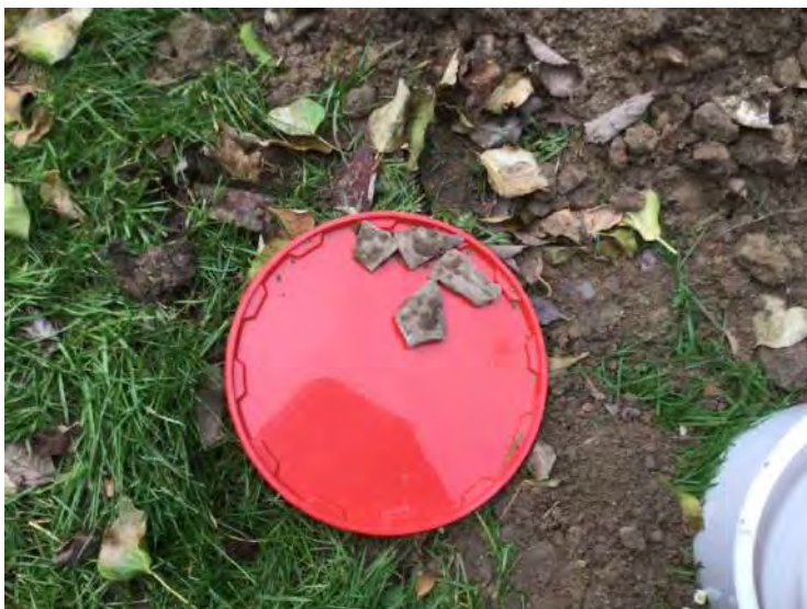
Inspectiegat IG15 grove fractie
