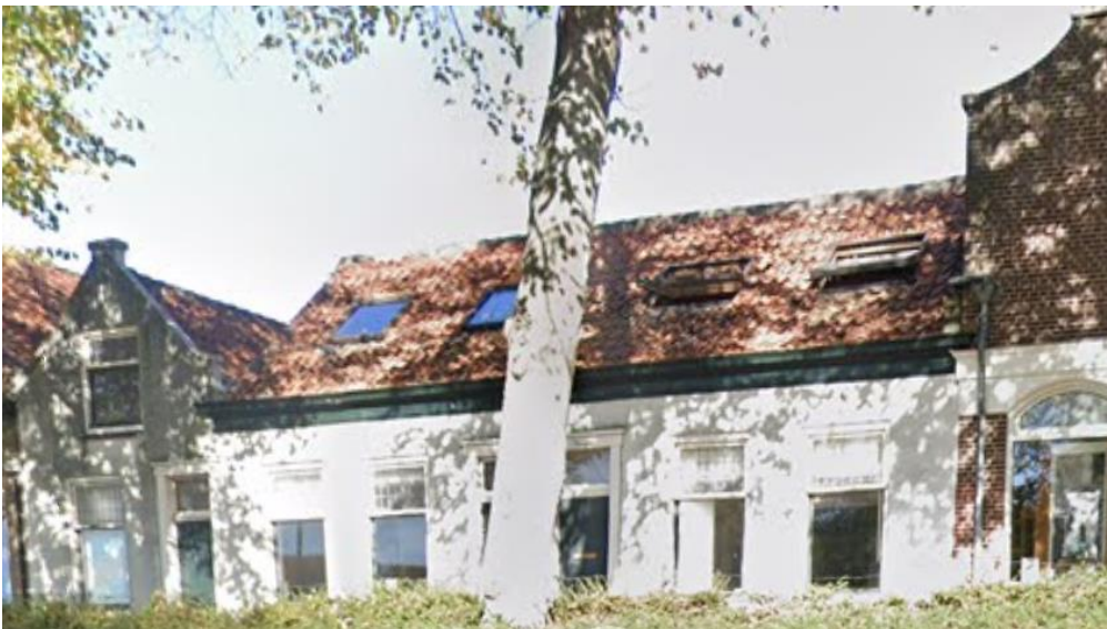
Figuur 1.1: foto voorgevel Zandpad 48 Middelharnis
